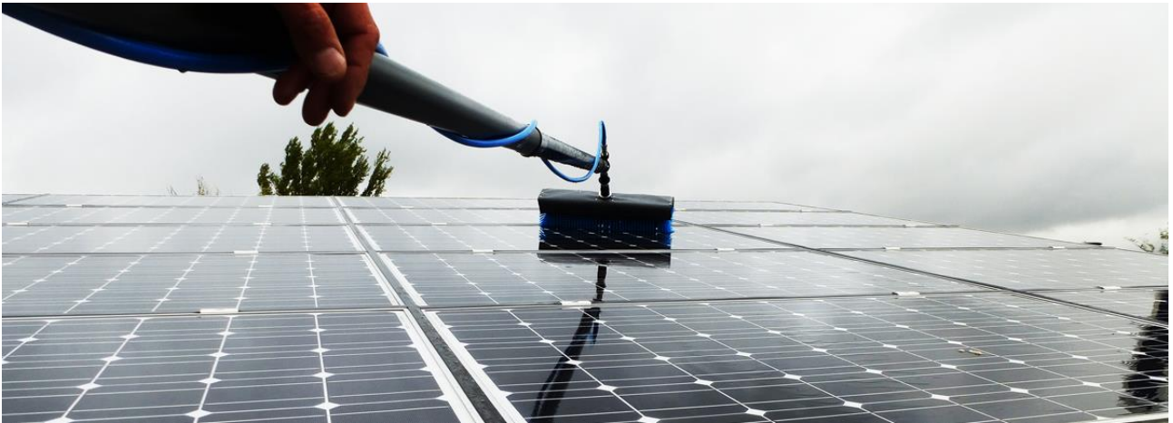
Macchina per il lavaggio manuale dei moduli e spazzola utilizzata per l'azione meccanica
