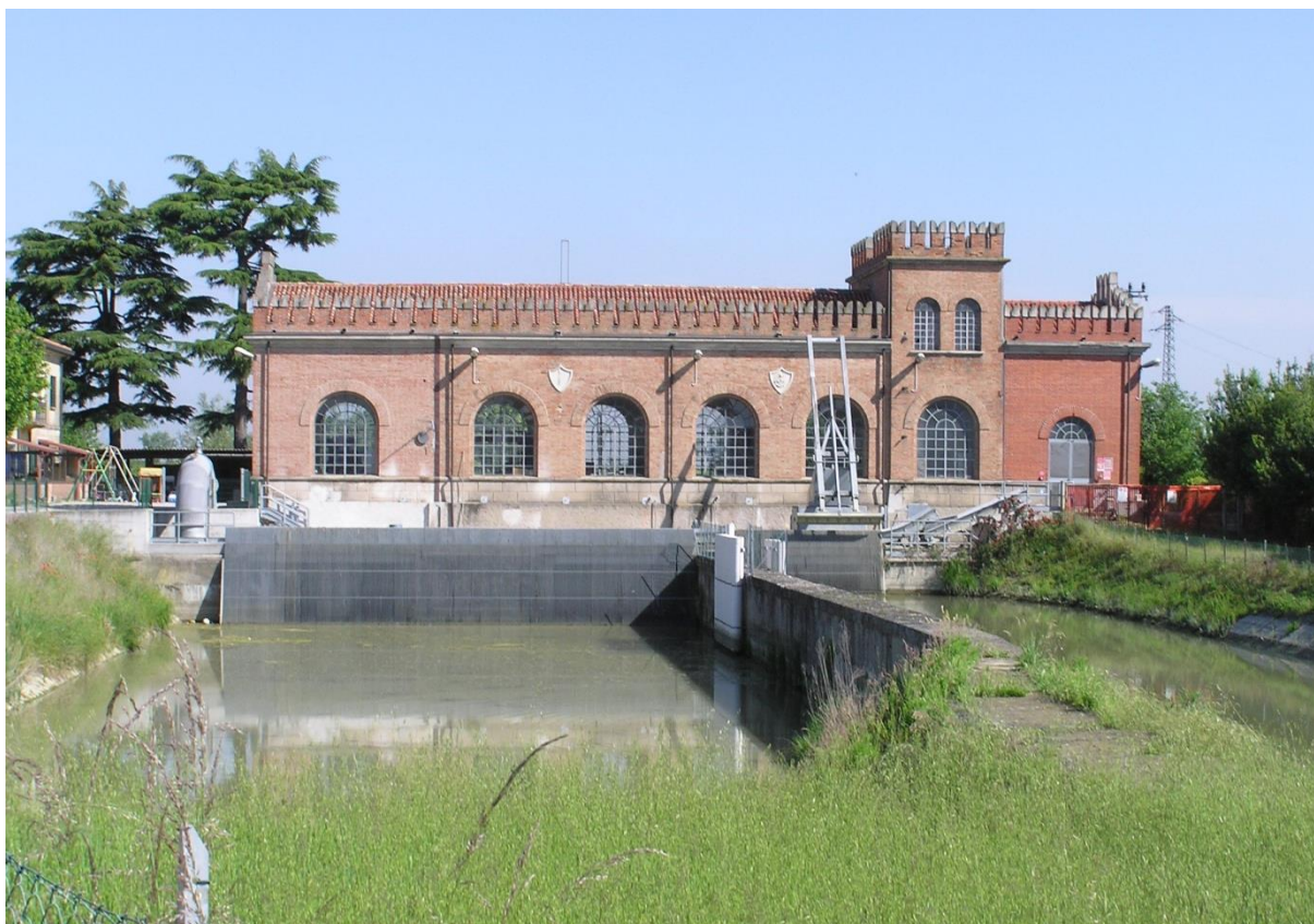
Figura 9. Vista da monte dell'idrovora Cattal. A sinistra il mandracchio del comparto delle acque basse, mentre il collettore delle acque medie raggiunge l'idrovora dietro al muro in primo piano.
