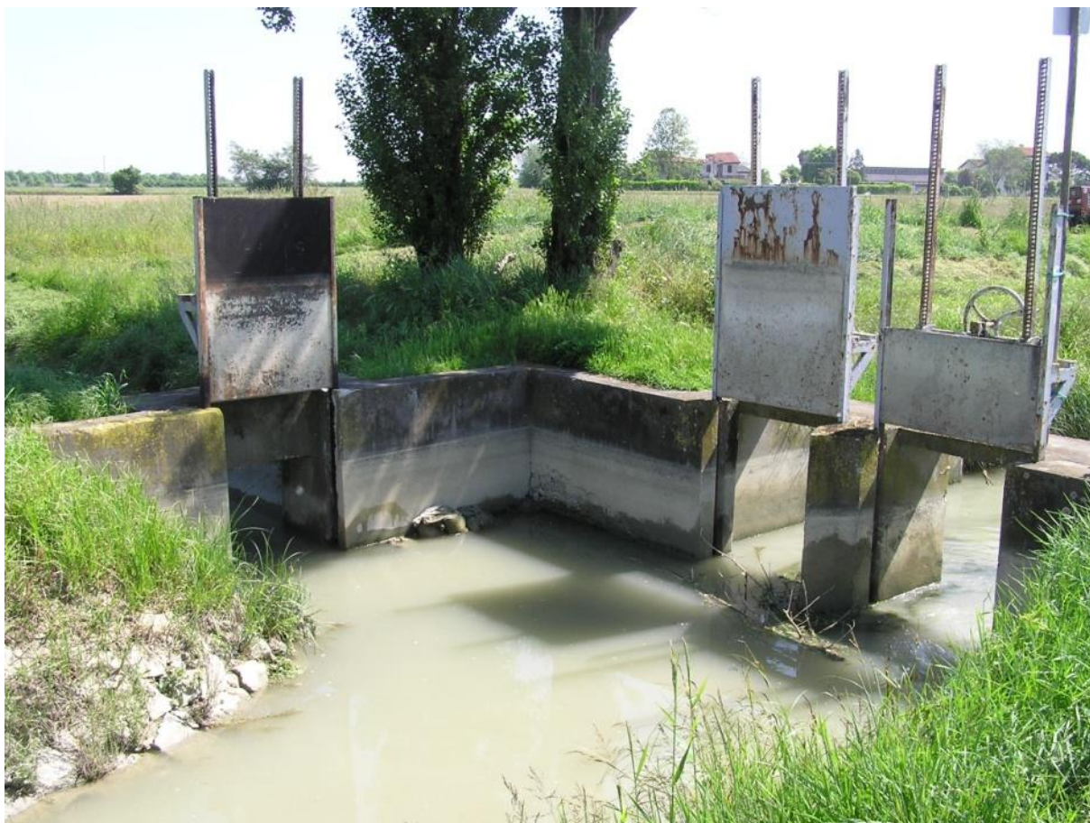
Figura 10. Manufatto partitore di portata posto lungo il collettore Acque Medie Cattal.
