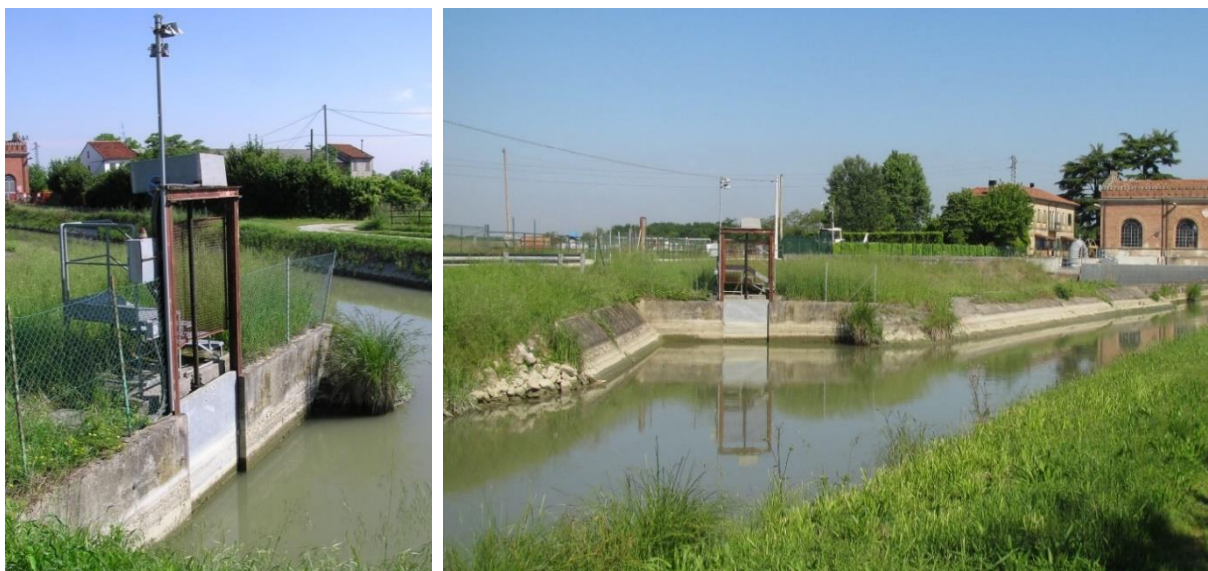
Figura 11. Vista della paratoia di collegamento delle Acque Medie Cattal con le Acque Basse Cattal in corrispondenza dell'idrovora Cattal.
