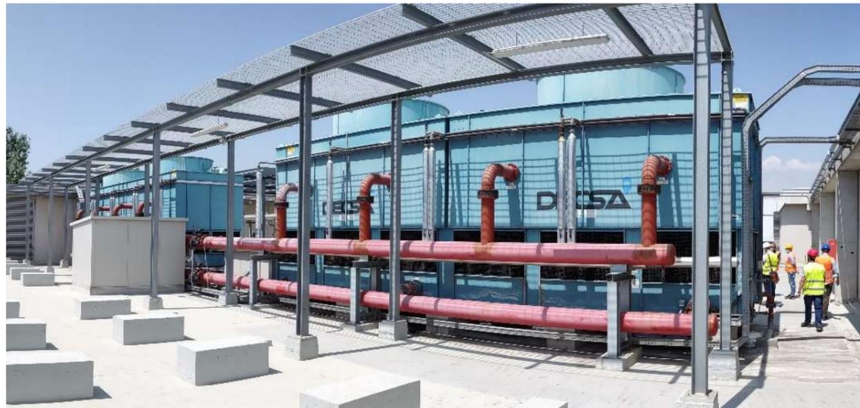
Figura 3-20 Torri evaporative dei gruppi frigo sulla copertura della centrale
