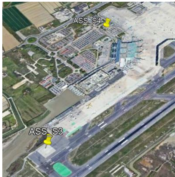
Figura 4-3 Localizzazione delle postazioni di rilievo acque sotterranee per la fase di costruzione
