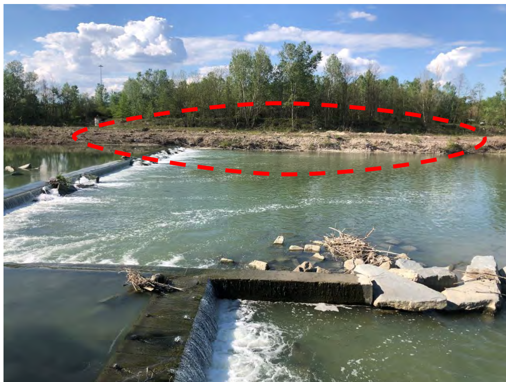
Fotografia 6 Vista della traversa esistente, viene indicata in rosso l'area interessata dal progetto della centrale sulla sponda sinistra del Fiume Tanaro
