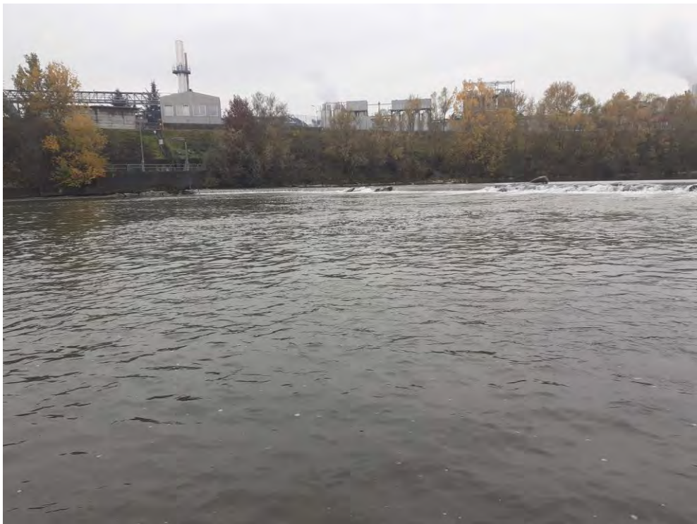
Fotografia 9 Vista a valle della traversa esistente
