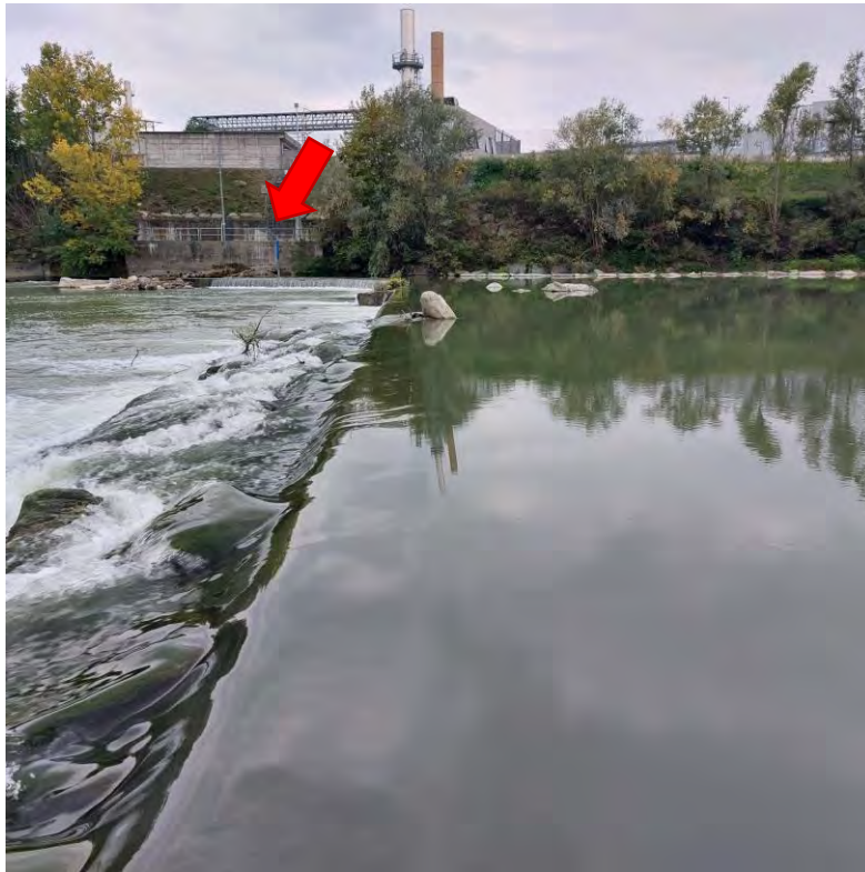
Fotografia 7 Vista della traversa esistente, sulla sponda destra del Fiume Tanaro viene indicata la traversa a servizio della derivazione industriale della Ferrero Industriale Italia S.r.l.
