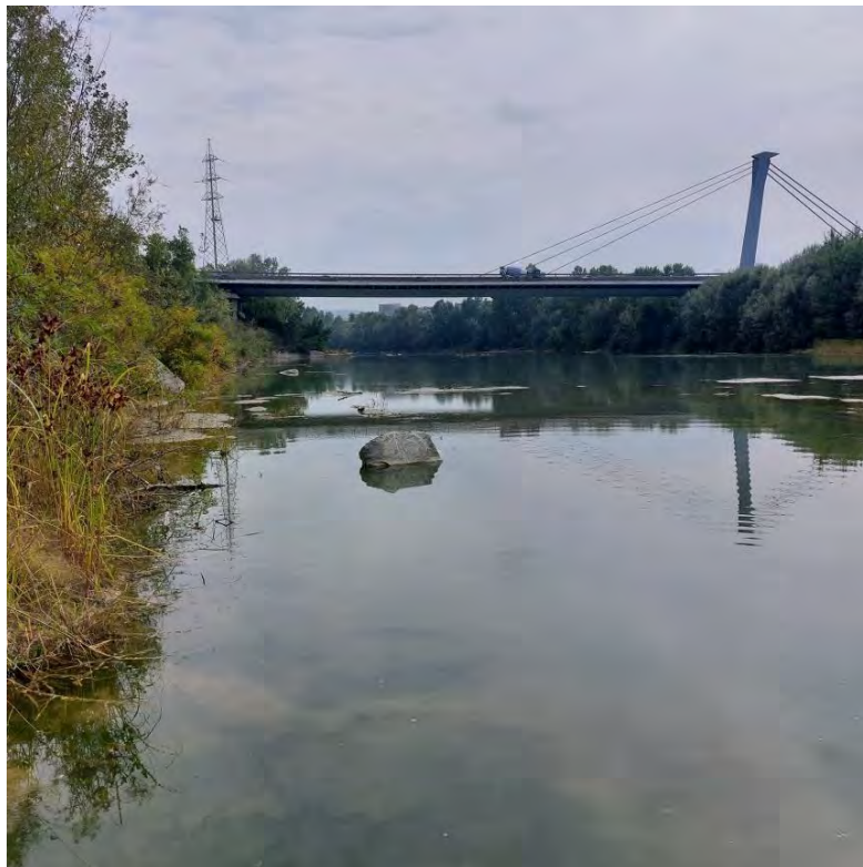
Fotografia 4 Vista verso monte del ponte dell'autostrada A33 Cuneo-Asti
