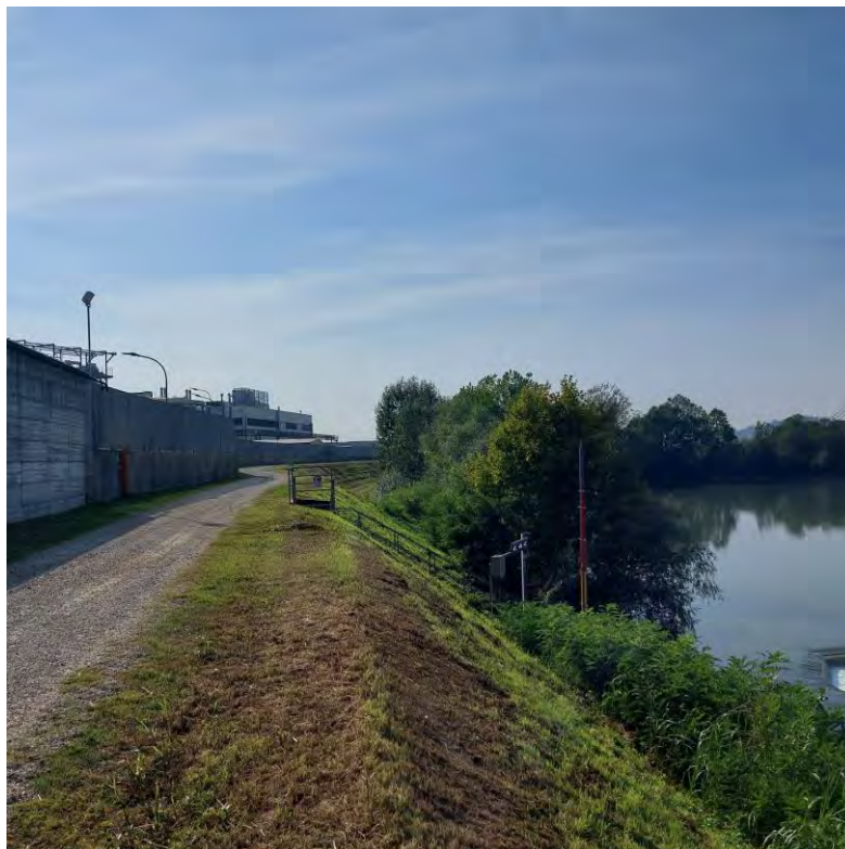
Fotografia 8 Vista della sponda destra del Fiume Tanaro in corrispondenza della traversa a servizio della derivazione industriale della Ferrero Industriale Italia S.r.l.
