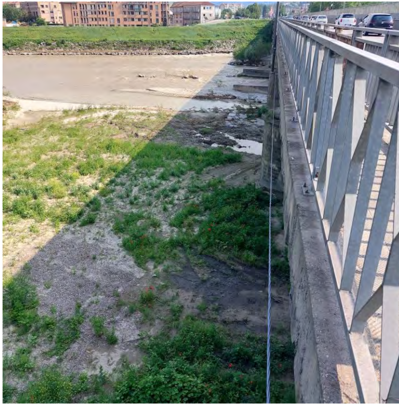
Fotografia 12 Vista a valle del ponte di Corso Canale
