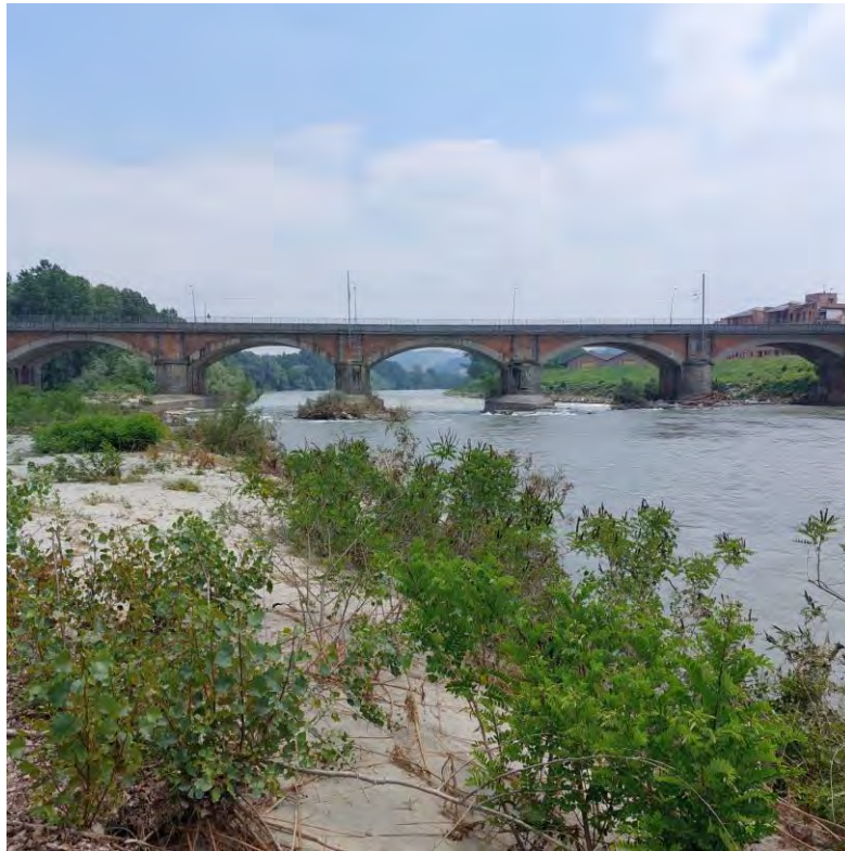
Fotografia 10 Vista del ponte di Corso Canale posto a valle della traversa in progetto
