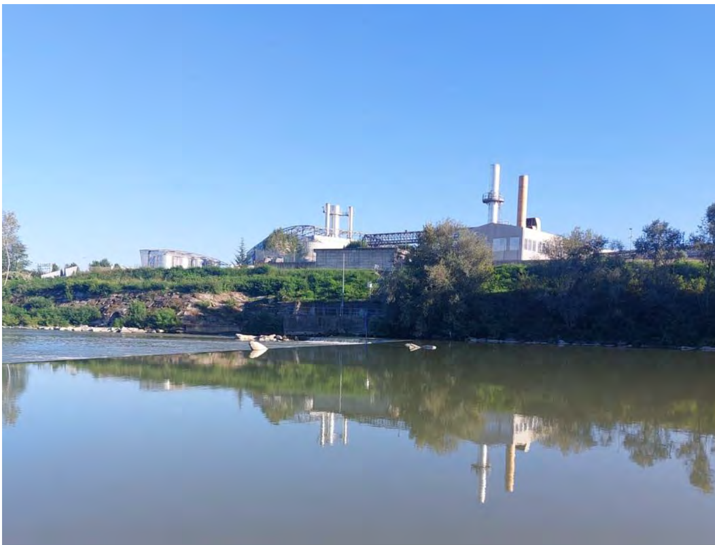
Situazione Esistente 3 Vista della traversa esistente con dettaglio sulle opere di derivazione della Ferrero Industriale Italia S.r.l.
