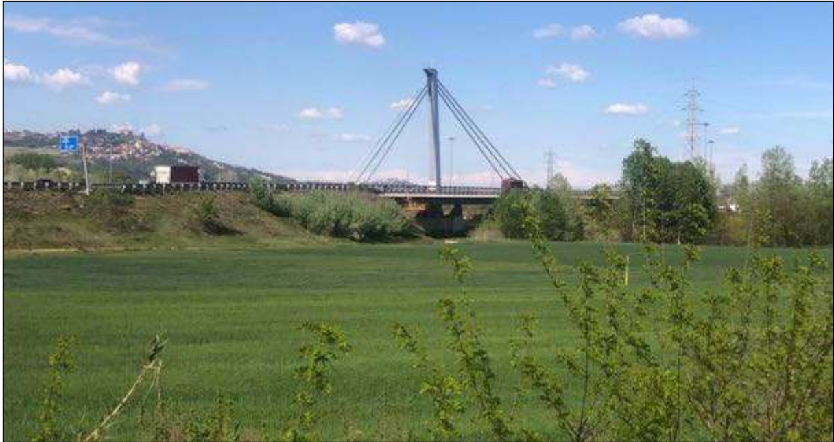
Figura 165: Ponte autostradale Caduti di Nassiriya a monte del sito
