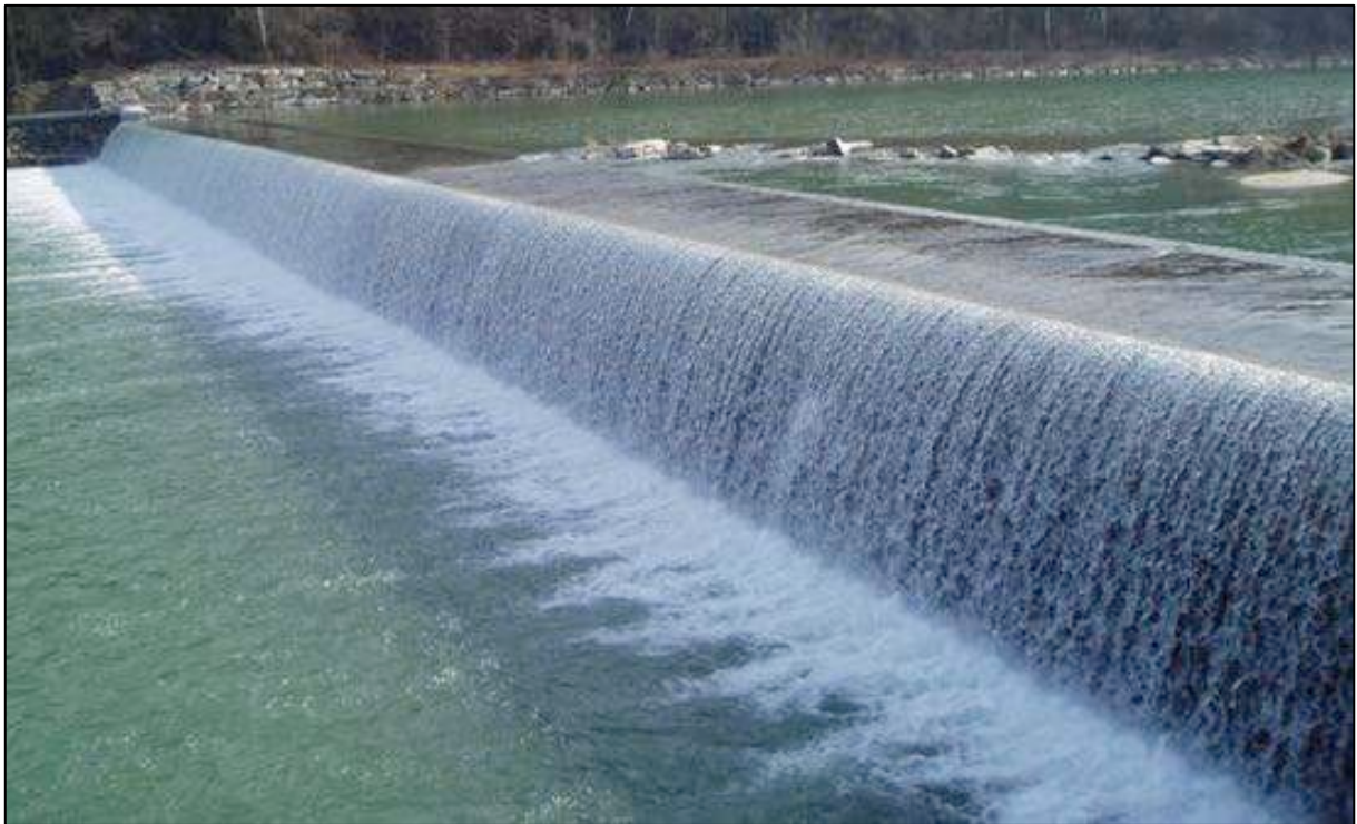
Figura 190: Aspetto scenico della cascata che si verrà a formare con sbarramento alzato ed impianto in esercizio
