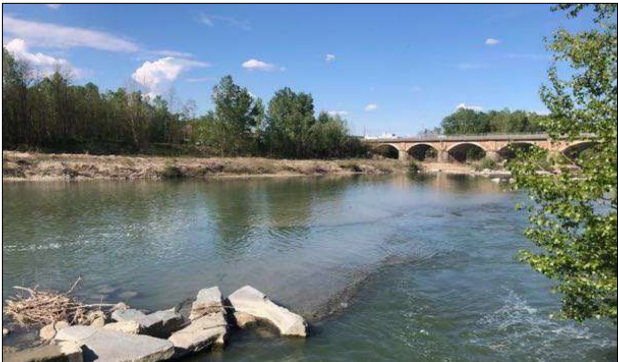
Figura 166: Ponte ferroviario e stradale di Corso Canale a valle del sito
