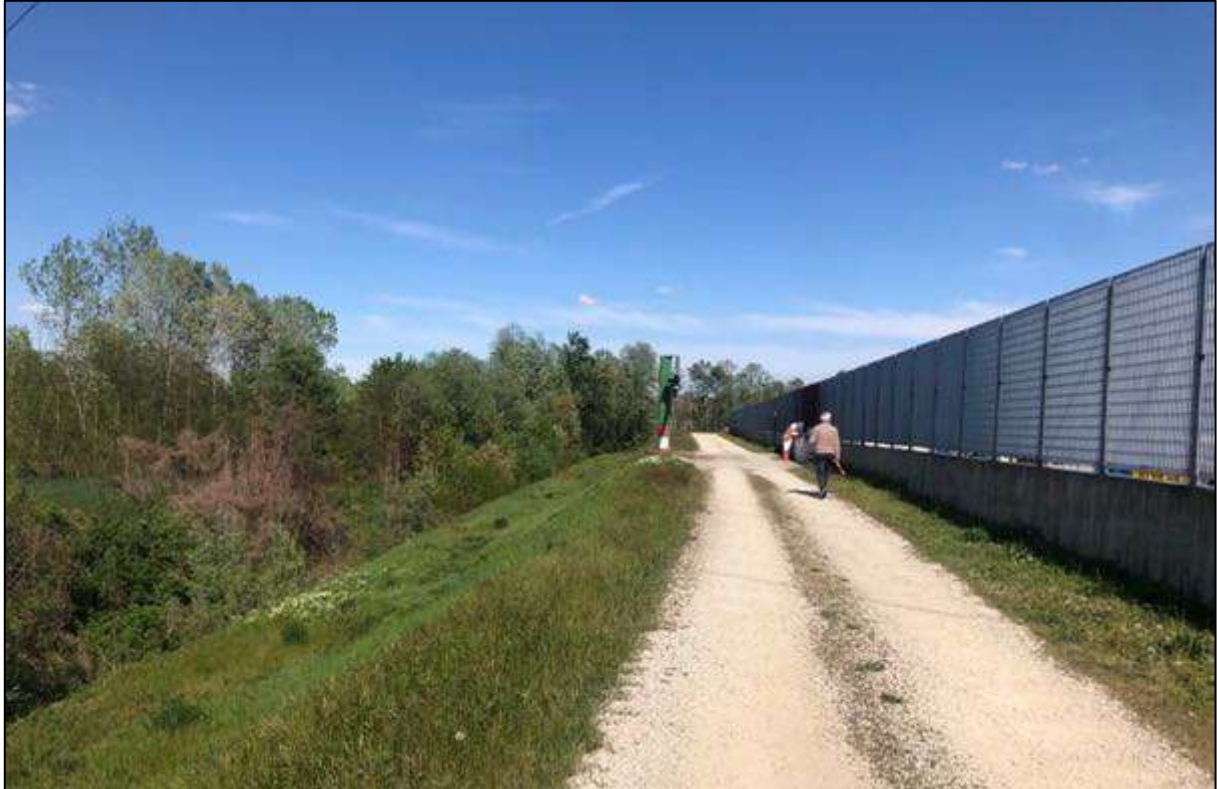
Figura 168: Argine destro del Fiume Tanaro e rete di cinta della zona industriale di Alba
