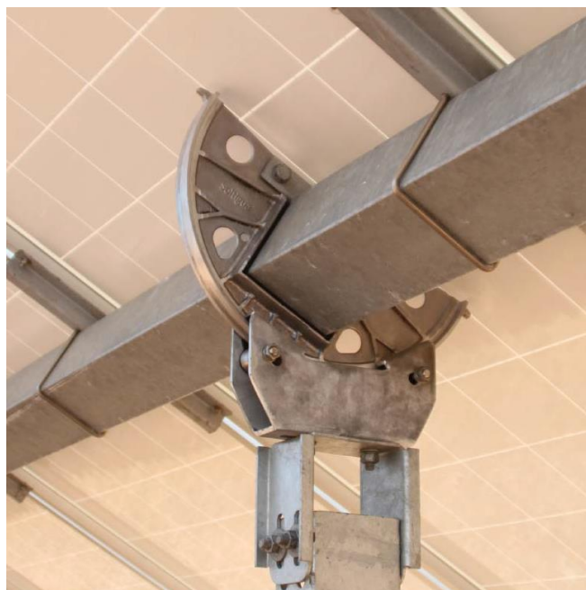
Schema nodo trave-pilastrino
