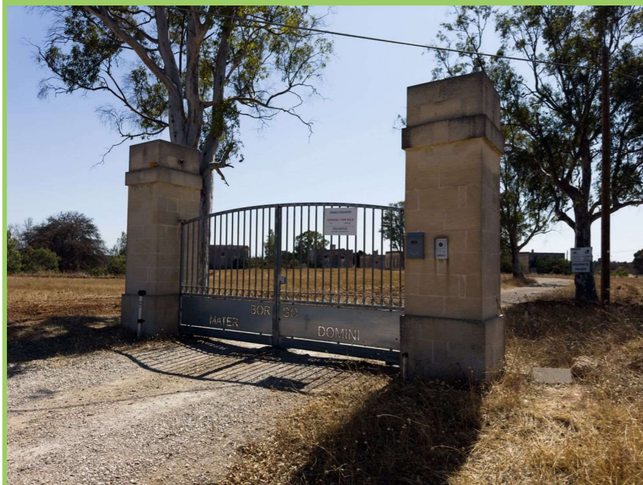
Foto 43. Colonne poderali (B.5.o) di ingresso al Borgo Materdomini (C.7.a).
