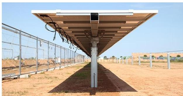
**Figura 5 Infissione tipo del palo del tracker nel terreno**
