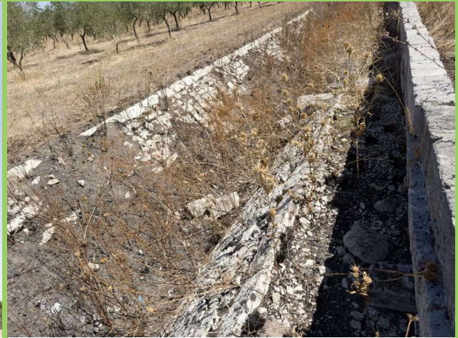
Foto 28. Sistema di canalizzazione delle acque della prima metà nel '900 (B.5.h.2).
