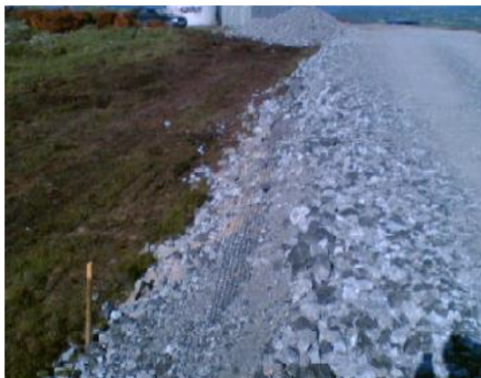
Figura 15: Superficie stradale in misto stabilizzato e drenaggio
