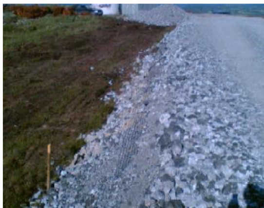
Figura 23: Superficie stradale in misto stabilizzato e drenaggio
