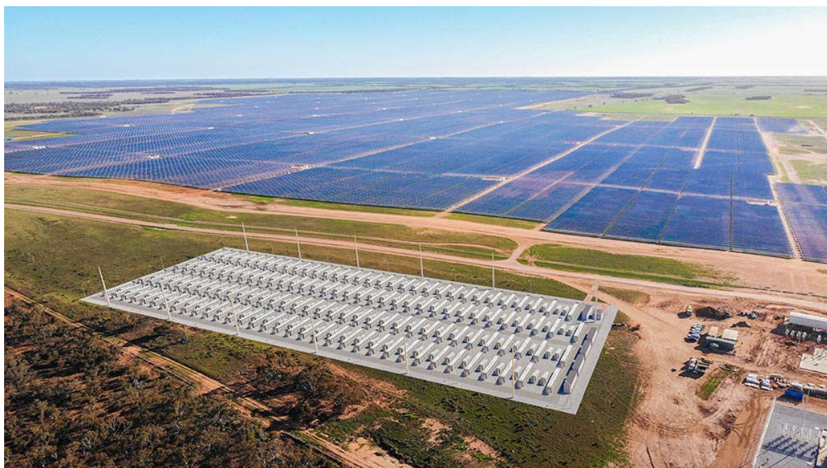
Immagine esempio di impianto BESS
