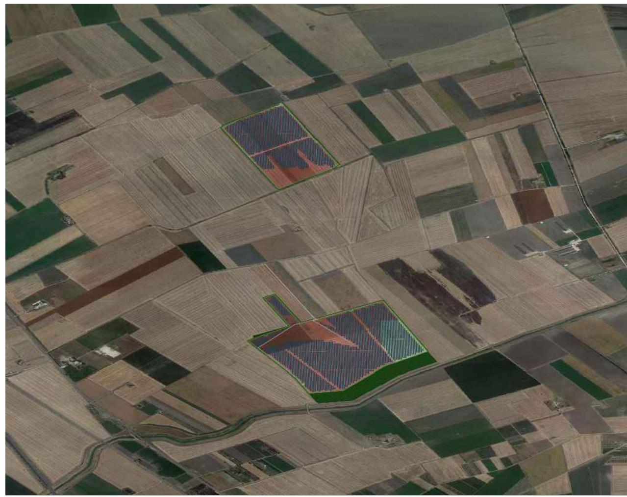
VISTA LATO NORD POST OPERAM
