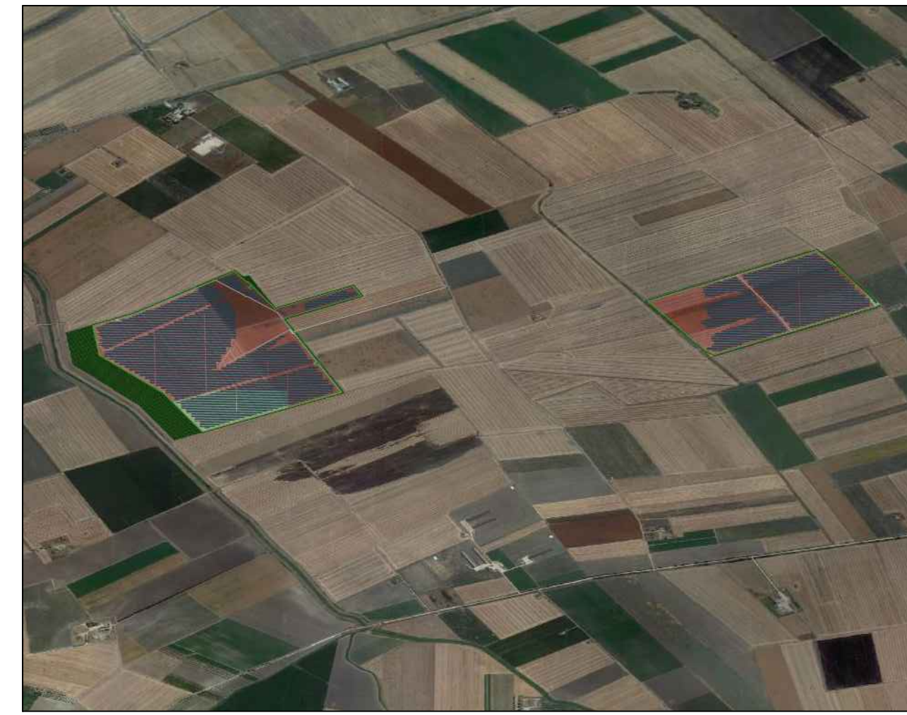
VISTA LATO OVEST POST OPERAM
