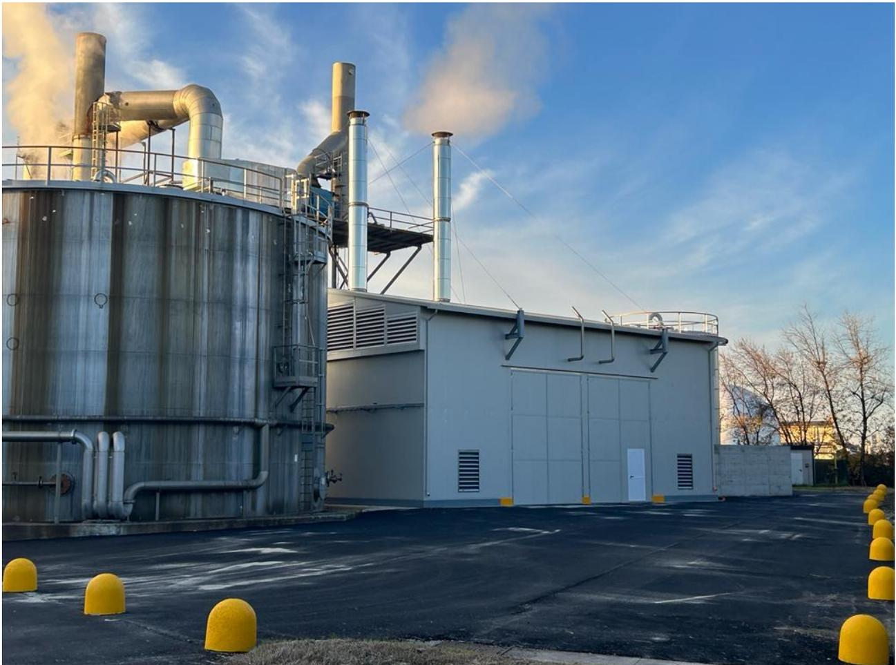
**Figura 31 - Nuova centrale termica ospitante i generatori di vapore C1 e C2 (emissioni E28 ed E29) - esterno**
