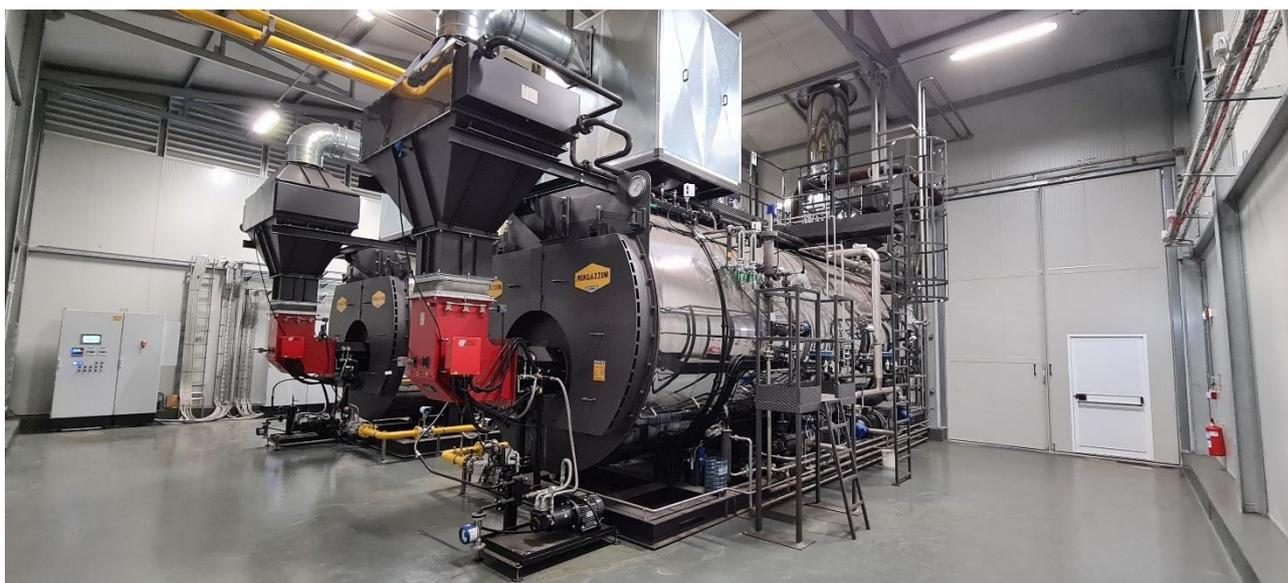
**Figura 30 - Nuova centrale termica ospitante i generatori di vapore C1 e C2 (emissioni E28 ed E29) - interno**
