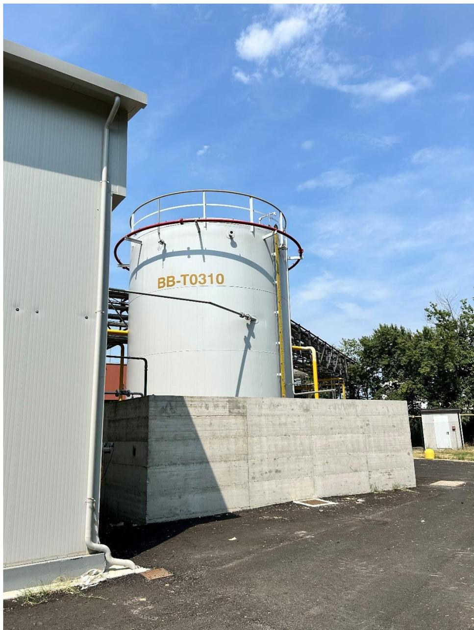
**Figura 33 – Nuovo serbatoio stoccaggio gasolio (emergenza) da 200 m<sup>3</sup> con bacino di contenimento in calcestruzzo armato**
