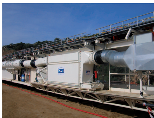
Foto 3 – Impianto abbattimento polveri dalla testa fresante del tipo a secco.
