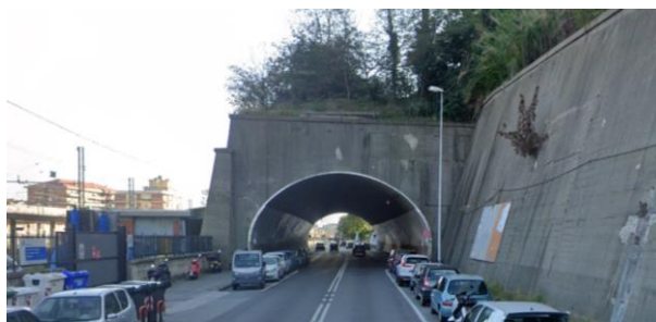
Figura 6 - Galleria insistente su Via Vittime di Brescia
