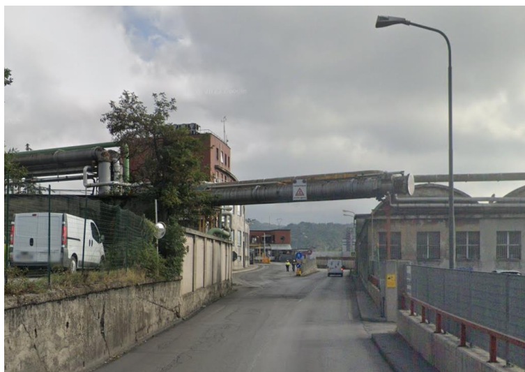
Figura 21 – Interferenza aerea in prossimità della centrale di cogenerazione
