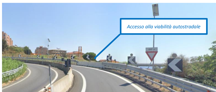
Figura 14 – Area accesso alla viabilità autostradale dall'area di proprietà della Vernazza Autogru S.r.l.
