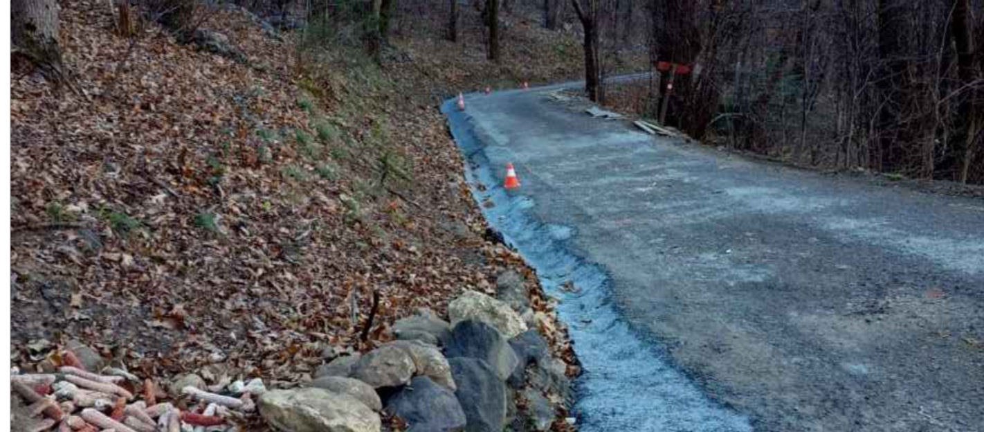
PARTICOLARE OPERE TRASVERSALI DI REGIMAZIONE DELLE ACQUE
