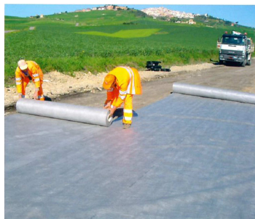
posa geostuoia di separazione
