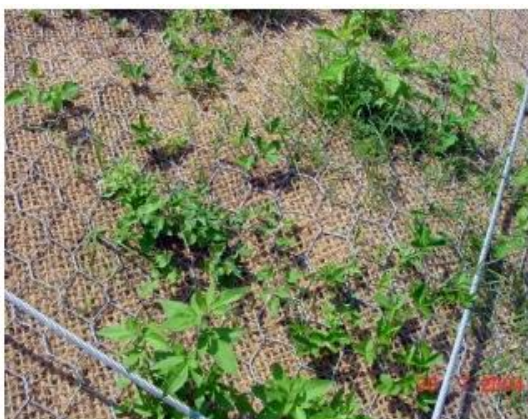
Figura 3 – particolare della vegetazione che cresce attraverso la biostuoia in cocco
