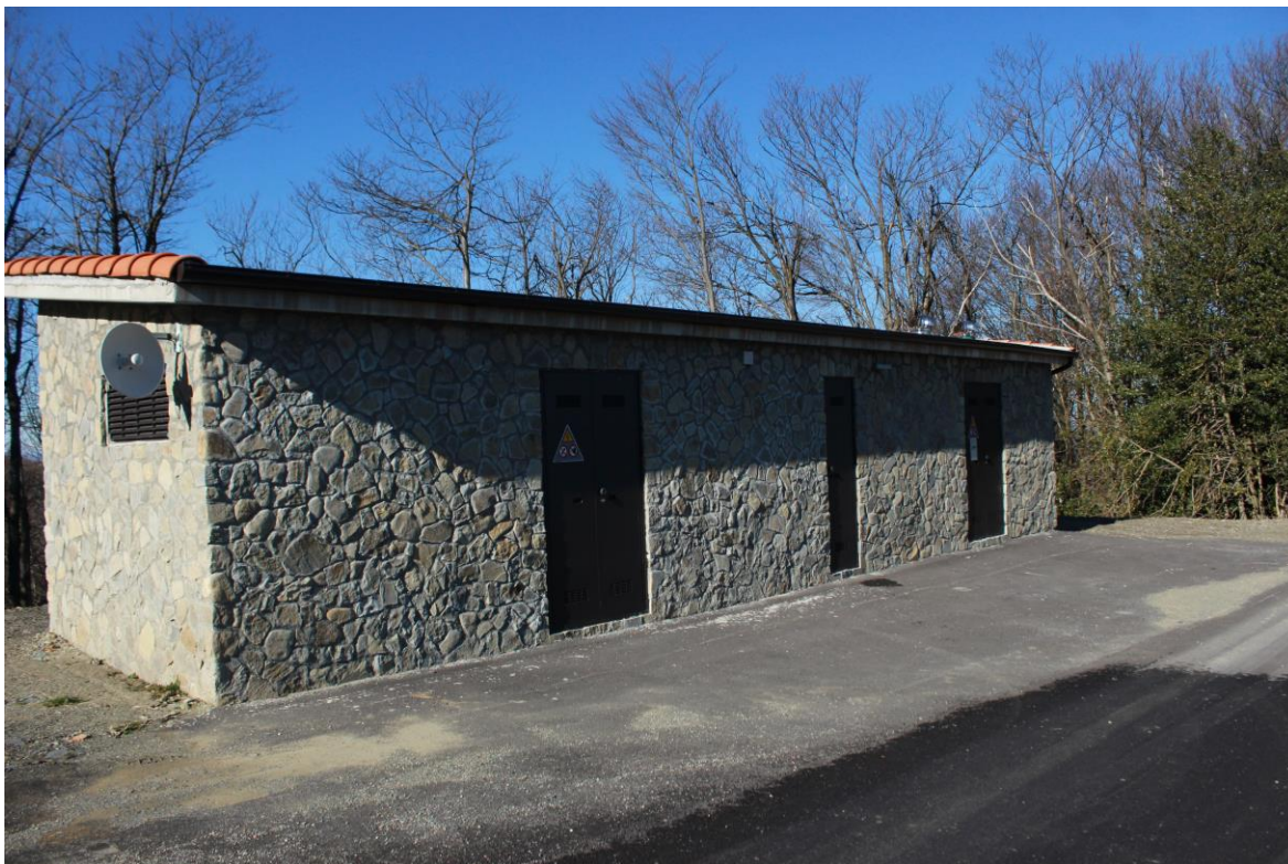
Figura 2 - esempio di cabina elettrica mitigata
