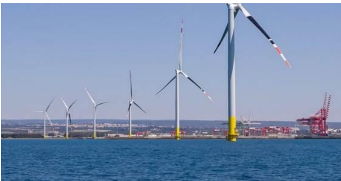
Figura 1 - vista del parco eolico realizzato nel porto di Taranto
