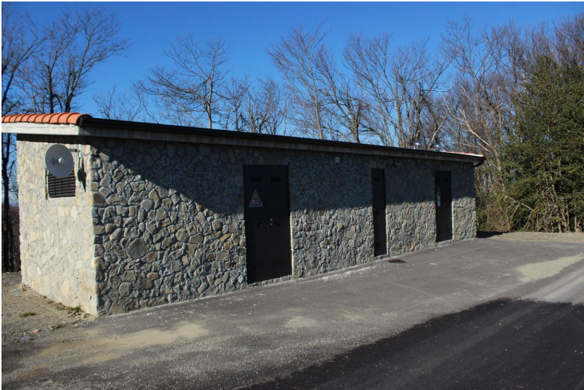
esempio di cabina elettrica mitigata
