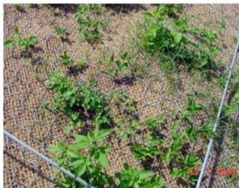
Particolare della vegetazione che cresce attraverso la biostuoia in cocco
