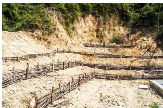
Esempio di realizzazione di una viminata
