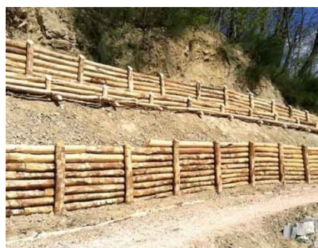
Esempio di palizzata
