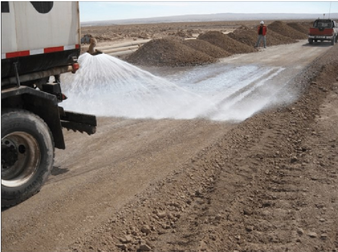
innaffiatura su strada di servizio contro sollevamento polveri
