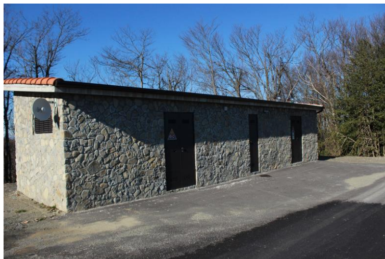
Figura 1 - esempio di cabina elettrica mitigata
