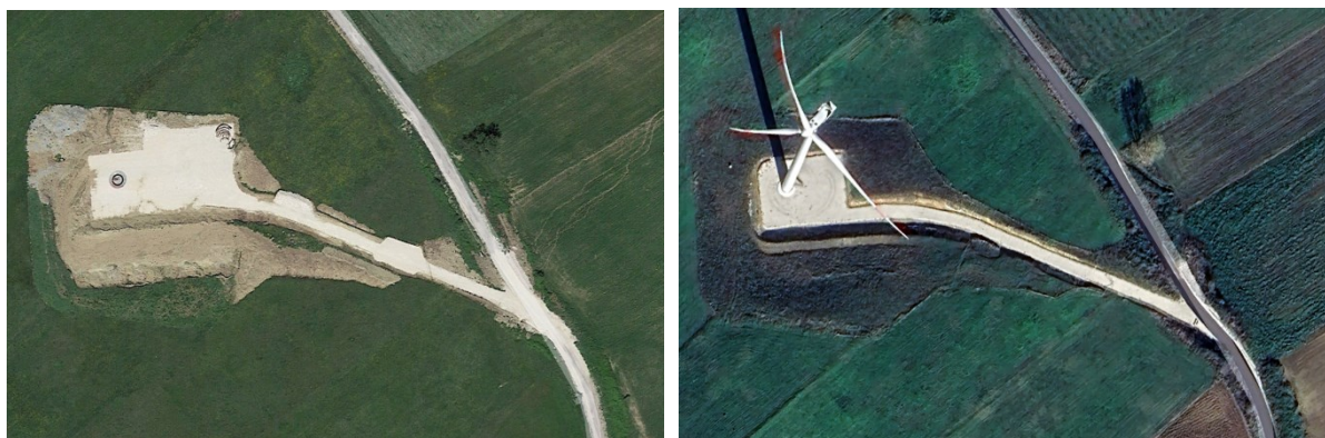
Piazzola in fase di cantiere
