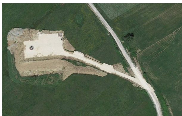
Piazzola in fase di cantiere
