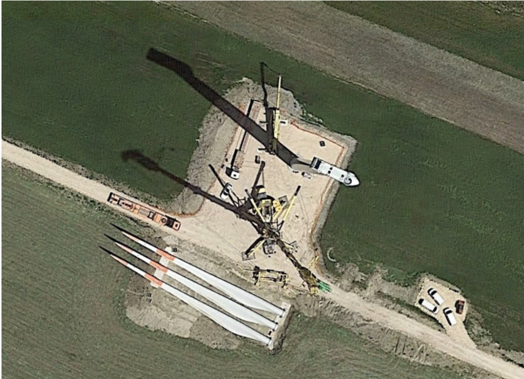
Figura 4.12: esempio di piazzola in fase di costruzione
