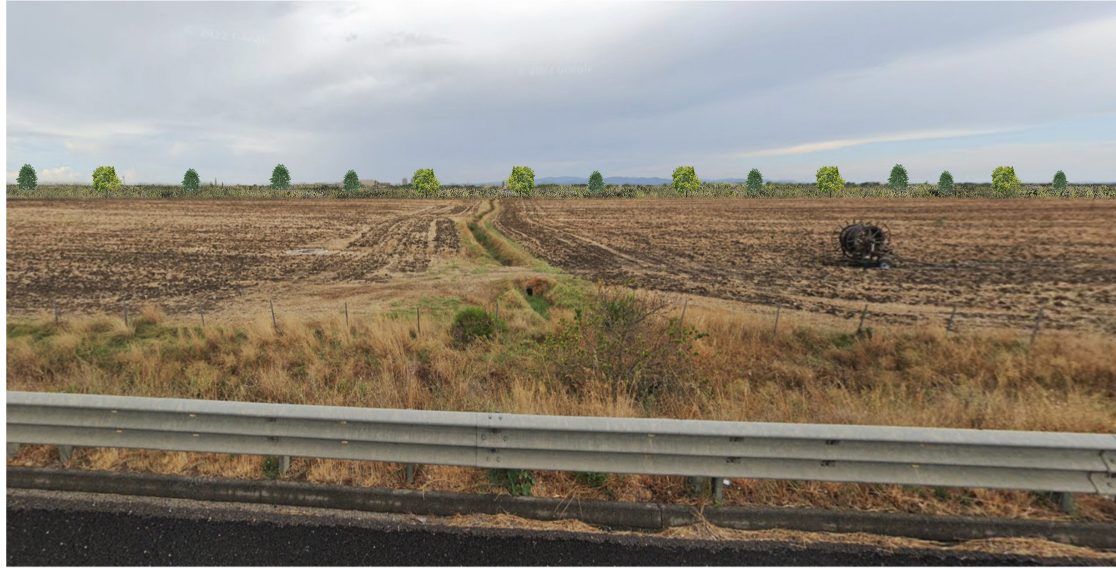
Foto 1.2: Vista dell'impianto dalla strada E80, al km 183 con opere di mascheramento come da progetto agronomico.
