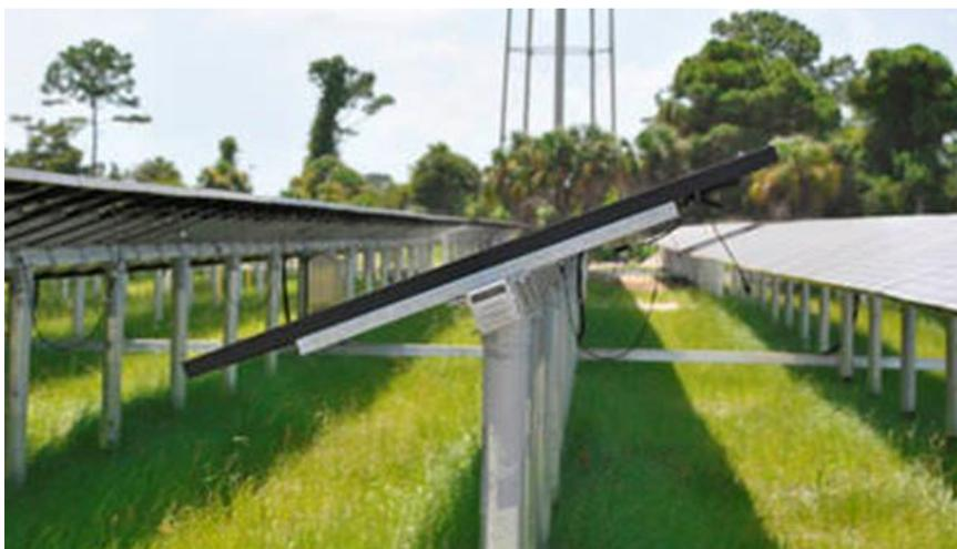
Figura tipologica impianto agrivoltaico 1P su Tracker monoassiale
