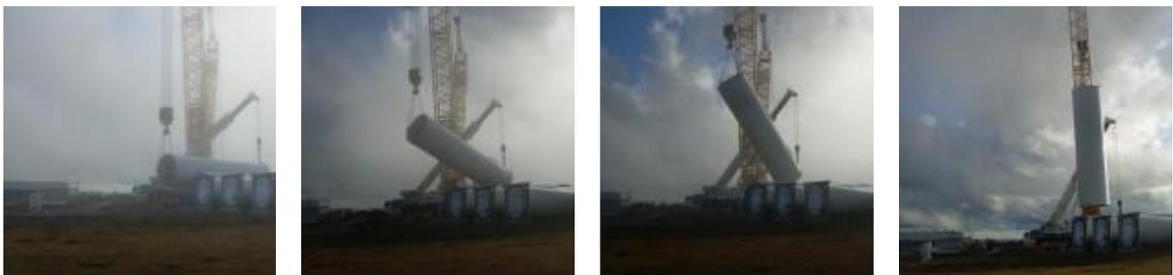
*Figura 5.16 – Schema delle fasi di sollevamento dei componenti dell'aerogeneratore (Fonte sito web <http://www.windfarmbop.com/> )*
