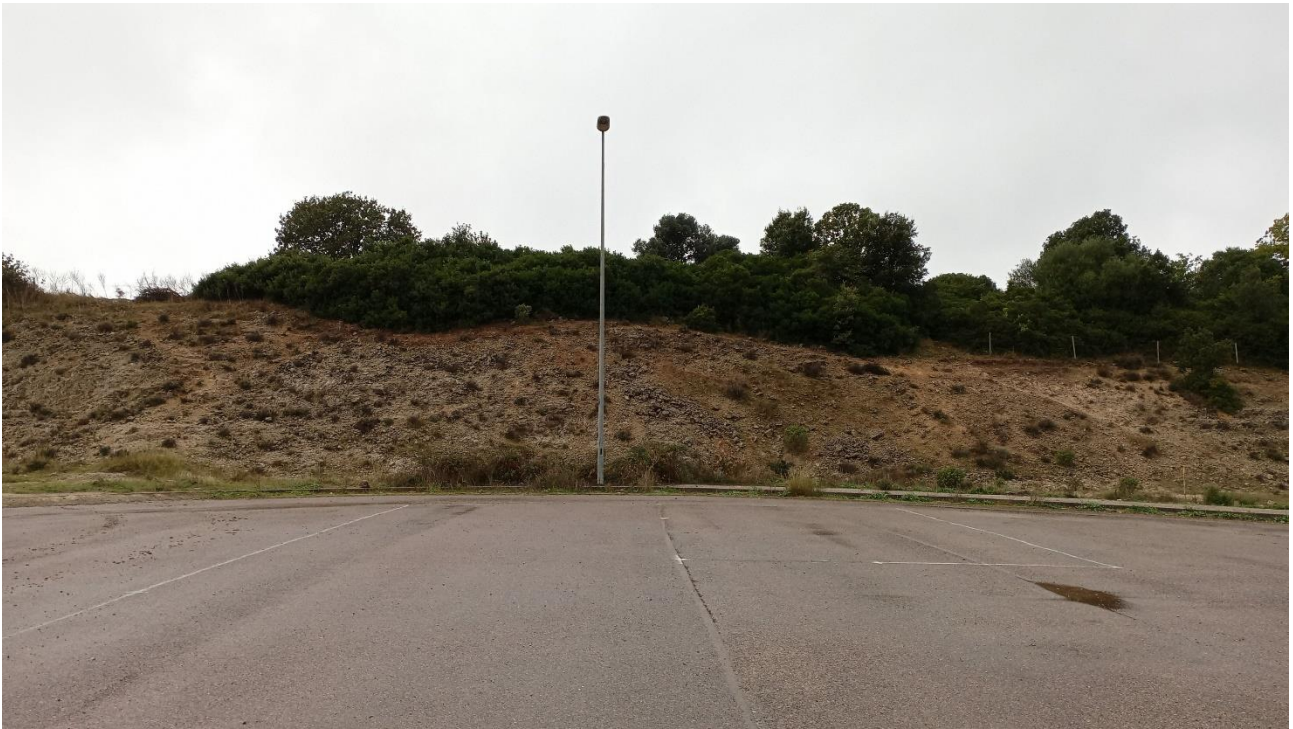
Figura 4.5 – Punto di inizio dalla viabilità di nuova realizzazione in prossimità della postazione WTG1 facente parte della viabilità di progetto (vista verso ovest)
