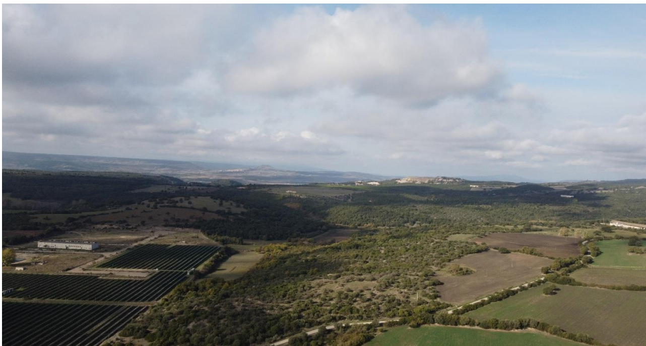
Figura 6.24 - Area di installazione degli aerogeneratori WTG3 e WTG1 rispettivamente a nord e a nord-ovest (in cima al M. Maggiore) dell'area industriale Perd'e Cuaddu e dell'impianto fotovoltaico presente. Foto scattata dai pressi della postazione del WTG3 in direzione est con sullo sfondo il Monte Arci
