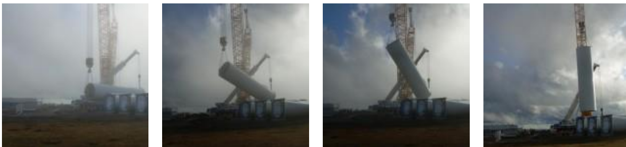
Figura 4.19 – Schema delle fasi di sollevamento dei componenti dell'aerogeneratore (Fonte sito web http://www.windfarmbop.com/ )
