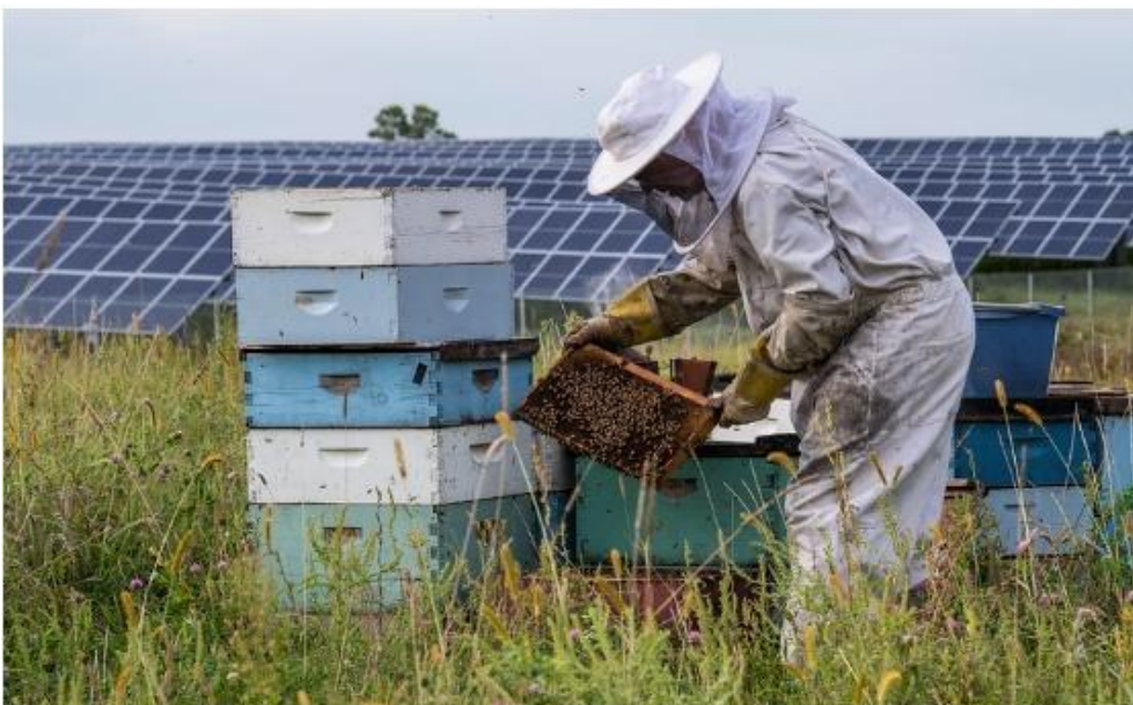
Figura 27: esempio installazione arnie in campo fotovoltaico.
