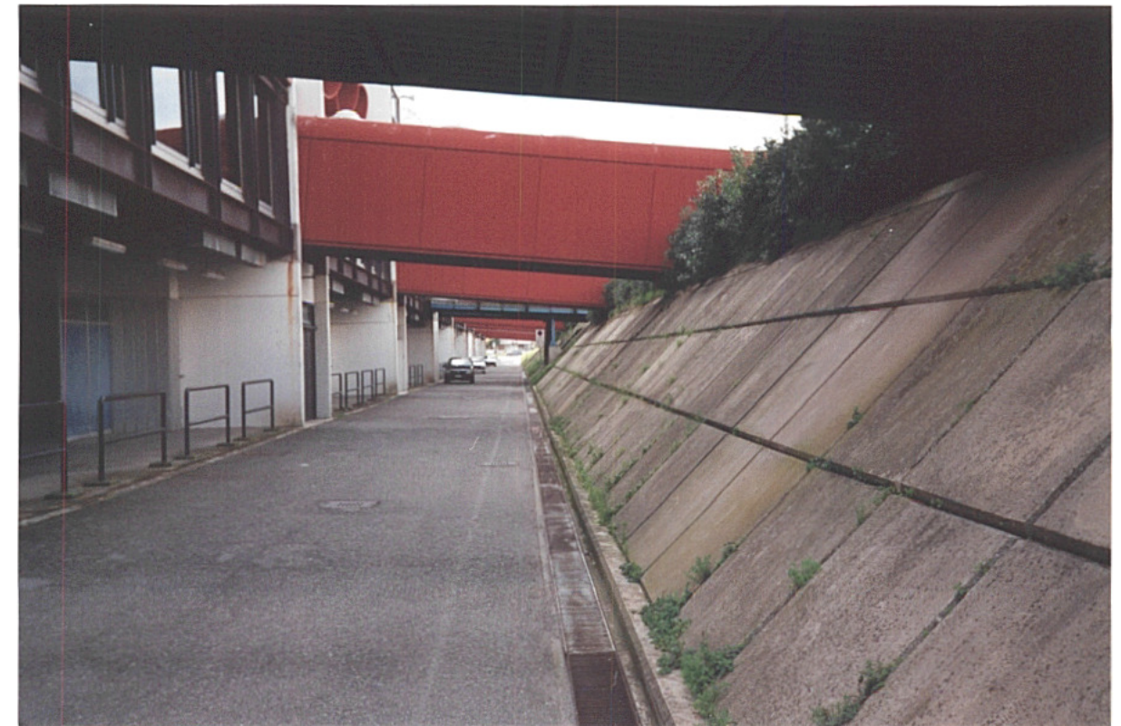
Foto n.4 – Viabilità di servizio per l'accesso al livello -2,70 dedicato ai servizi tecnici
