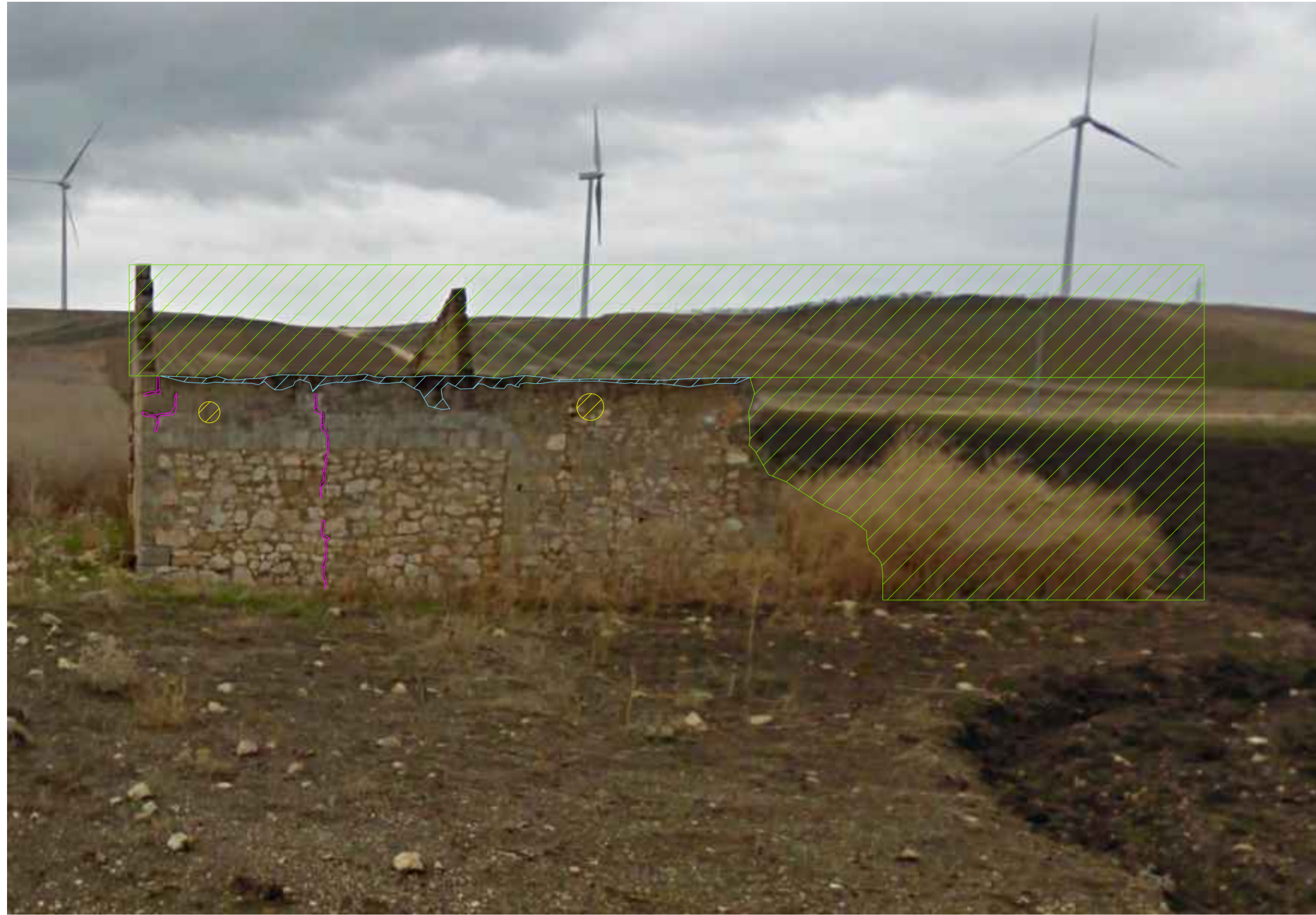
PUNTO DI RIPRESA FOTOGRAFICA NR. 1 - PROSPETTO NORD OVEST
