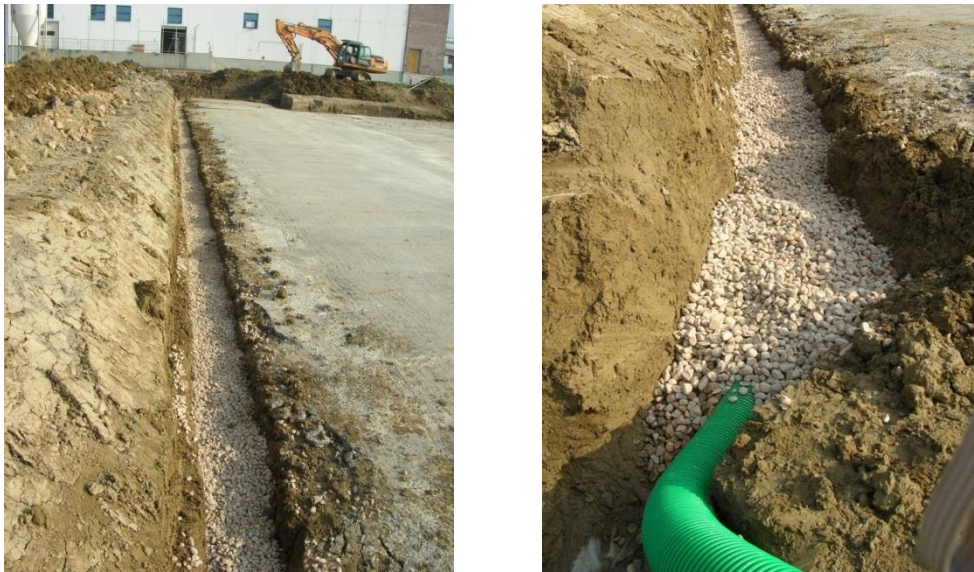
Figura 3-1 Disposizione tubo drenante all'interno di un drenaggio costituito da ghiaia
