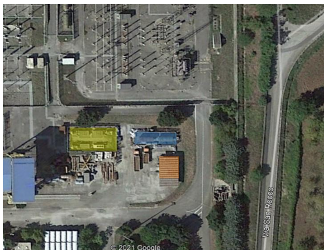
Figura 6-11 - Area di intervento in azzurro i serbatoi olio e in giallo le UTA. In arancione la Tettoia Fusti olio
