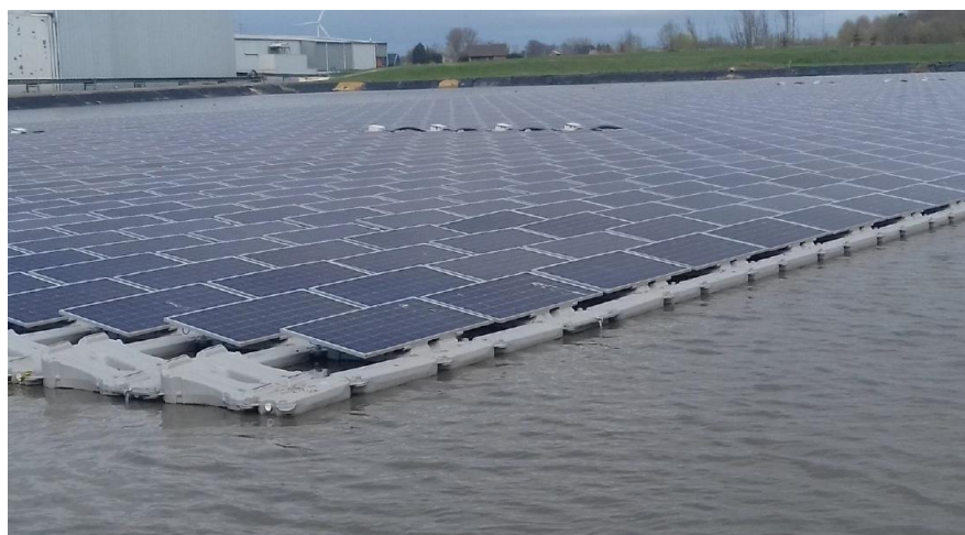
Figura 6-4 : esempio di struttura tipica portamoduli
