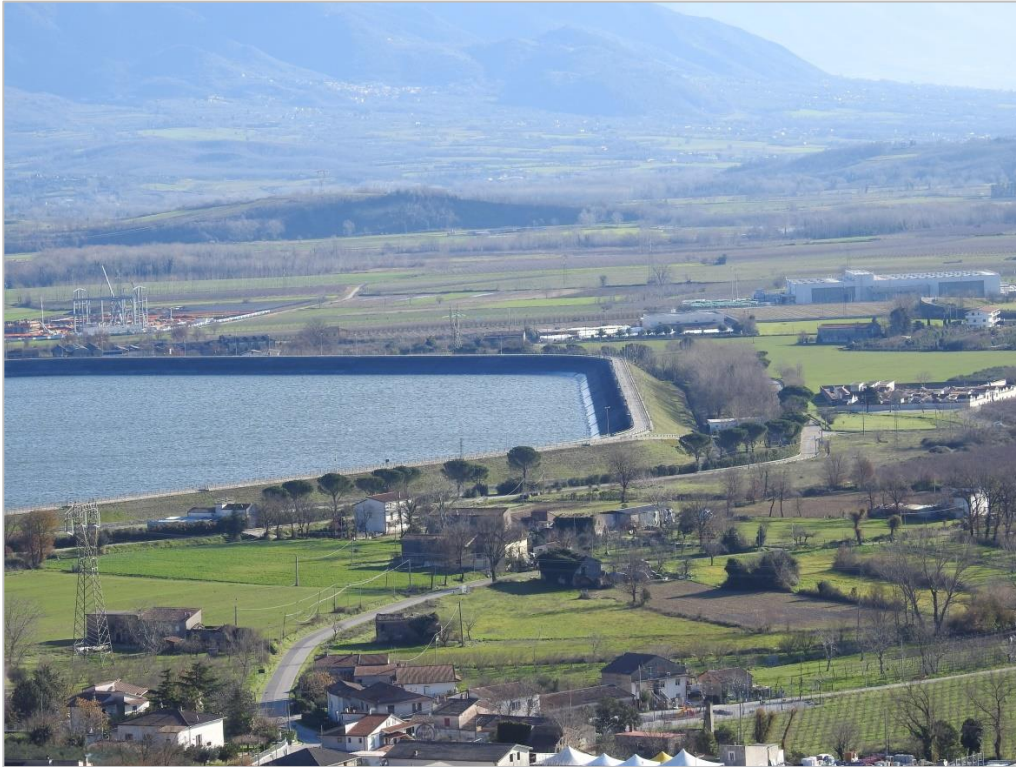
Figure 8-5. Lungo il bordo del bacino idrico, su terreni agricoli o industriali sono localizzate le aree di cantiere (baraccamenti, aree di montaggio, stoccaggio rifiuti, ecc.)
