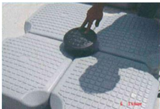
Figura 6-3: Installazione dei connettori centrali (4 unità collegate)
