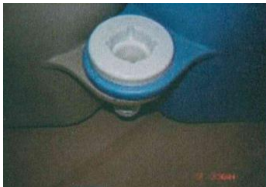
Figura 6-4: Installazione dei connettori laterali (2 unità collegate)
