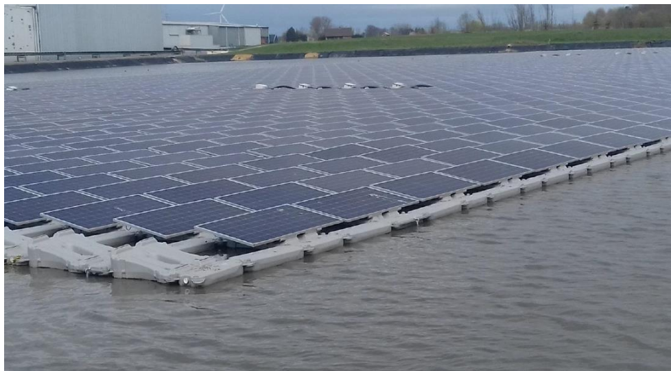
Figura 6-5 : esempio di struttura tipica portamoduli
