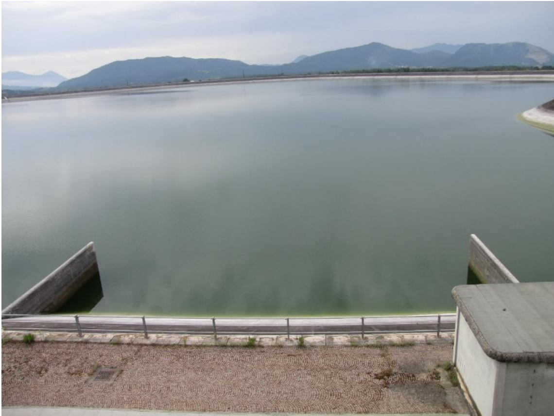
Figura 2-19 - Vista del bacino dal lato Nord - Ovest
