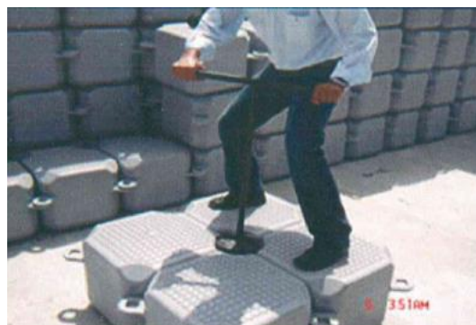
Figura 6-3: Installazione dei connettori centrali (4 unità collegate)
