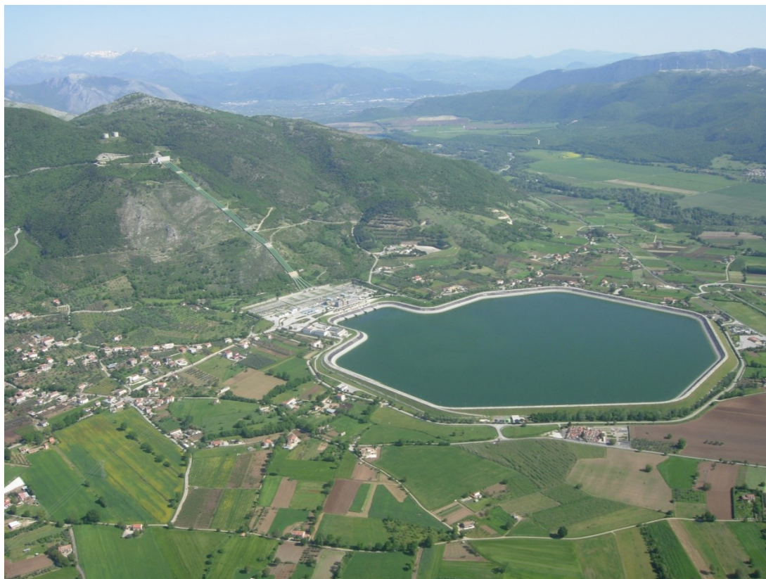
Figura 5-34 Veduta aerea del bacino inferiore
