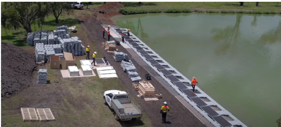
Figura 4-13 Esempio di area di assemblaggio struttura e varo in acqua (1)
