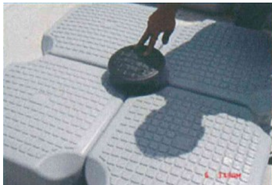
Figura 4-9: Installazione dei connettori centrali (4 unità collegate)
