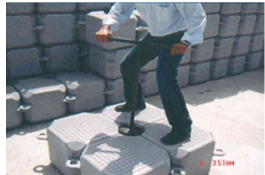
Figura 4-9: Installazione dei connettori centrali (4 unità collegate)
