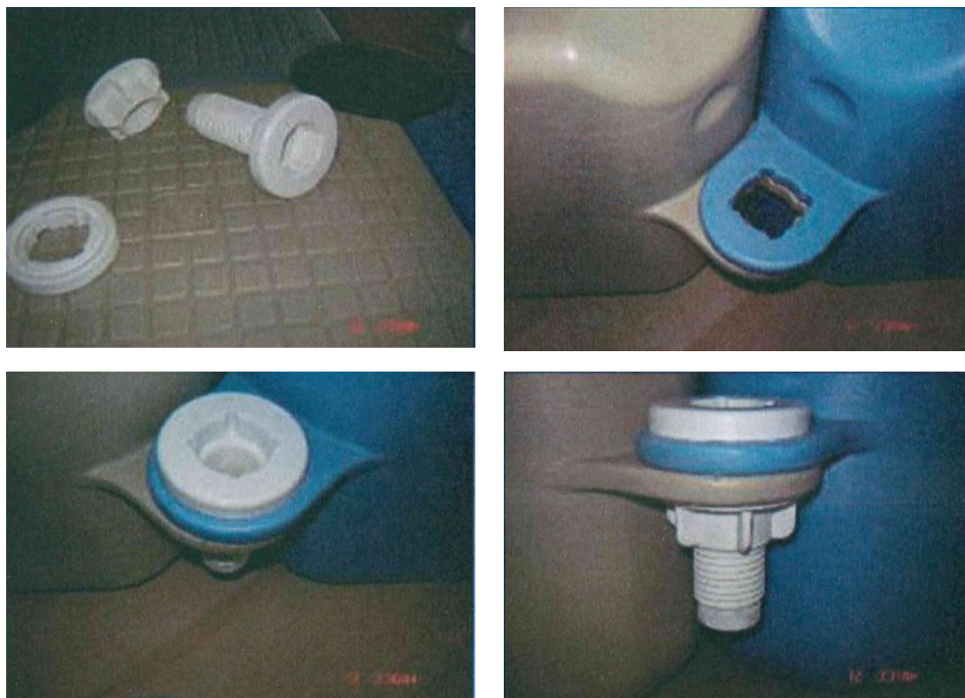
Figura 4-10: Installazione dei connettori laterali (2 unità collegate)
