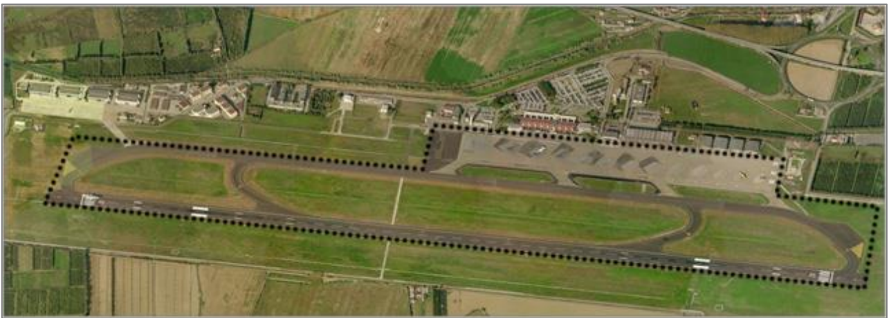
Figura 9-33 Vista a volo di uccello dell'Aeroporto di Lamezia: le infrastrutture di volo
