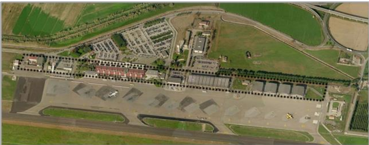
Figura 9-34 Vista a volo di uccello dell'Aeroporto di Lamezia: l'edificio
