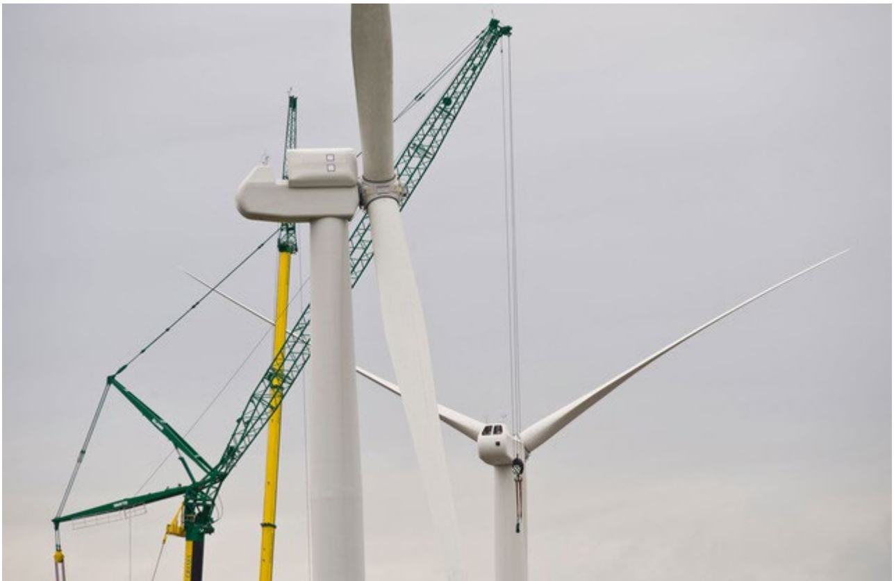
Figura 2- posa in opera aerogeneratori
