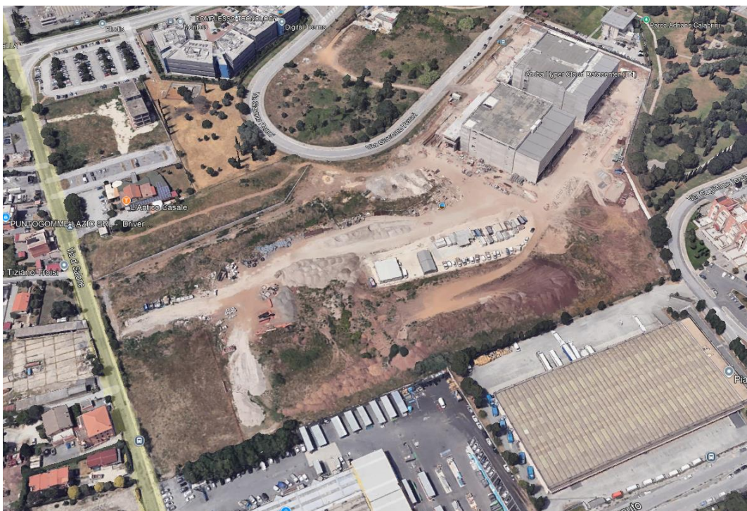
Figura 1: Il Data Center Aruba, Roma
