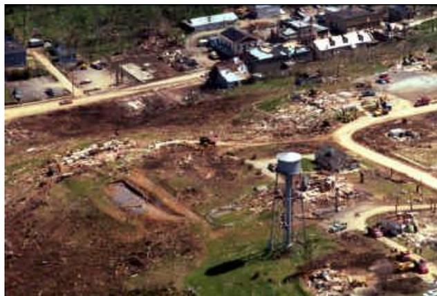
Figura 9- Esempio concreto di una struttura industriale (serbatoio sopraelevato di acqua) rimasta indenne nel mezzo di una zona di strutture residenziali distrutte da un tornado
