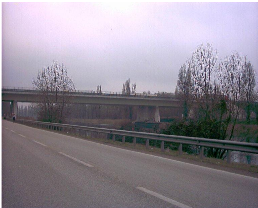
Figura 6 – Ponte Autostrada A4
