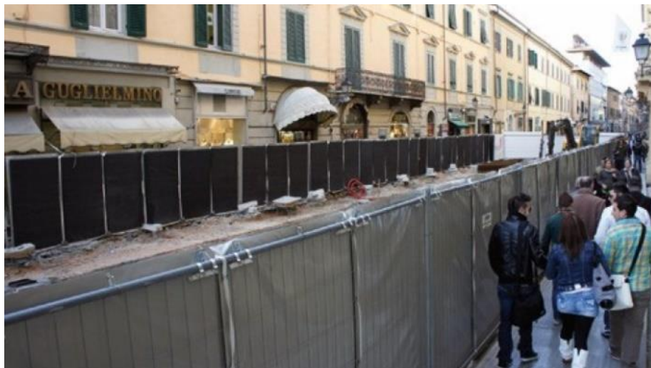
Barriere di confinamento costituite da pannelli fono-assorbenti
