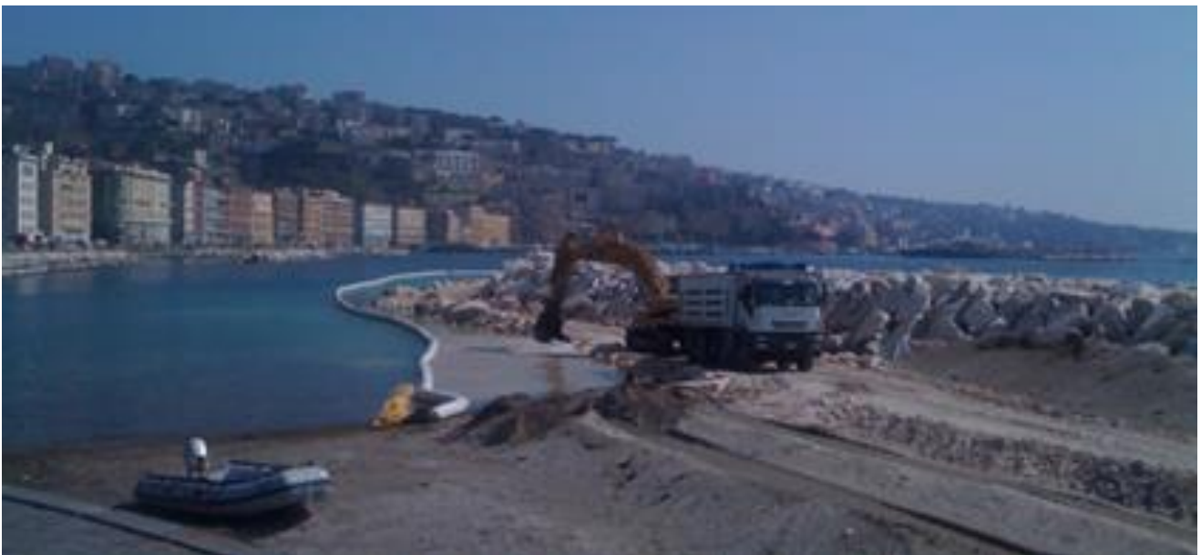
Panne galleggianti antitorbidità – esempio di impiego in casi similari
