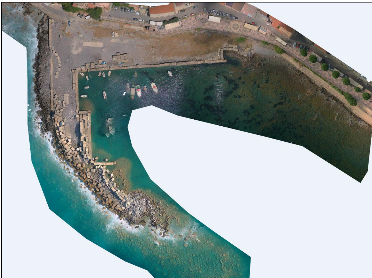
Aerofotogrammetria dell’area portuale realizzata con drone
