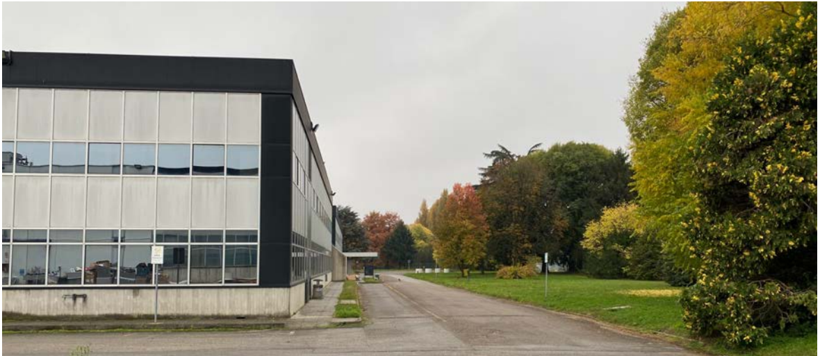
Figura 6-46 | Presenza di vegetazione all'interno del sito ex Italtel prima dell'avvio delle demolizioni degli edifici esistenti.
