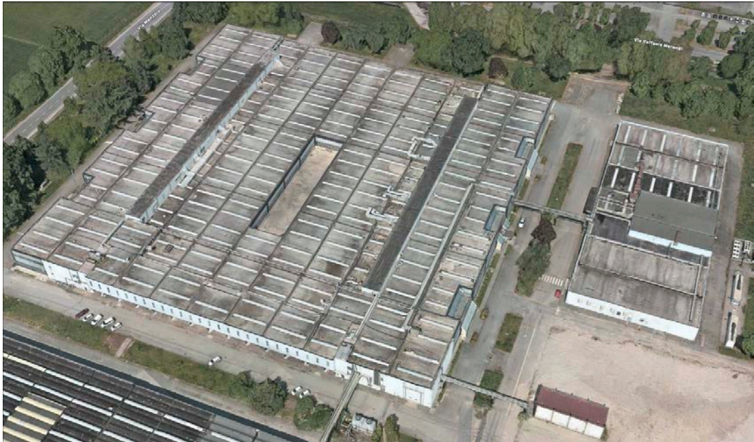
Figura 1-2 | Immagine a volo d'uccello dell'edificio attualmente in demolizione.
