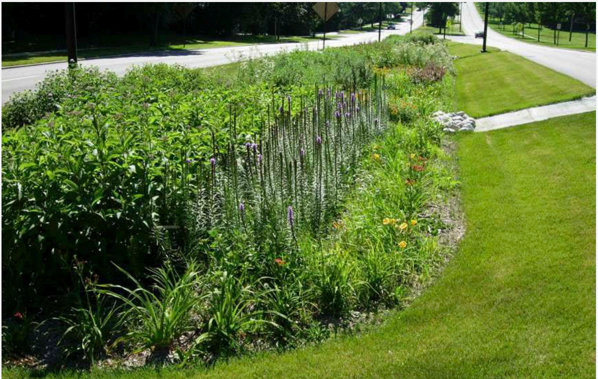
Figura 6-50 | Esempio di un bioswale (fonte https://www.reliance-foundry.com )
