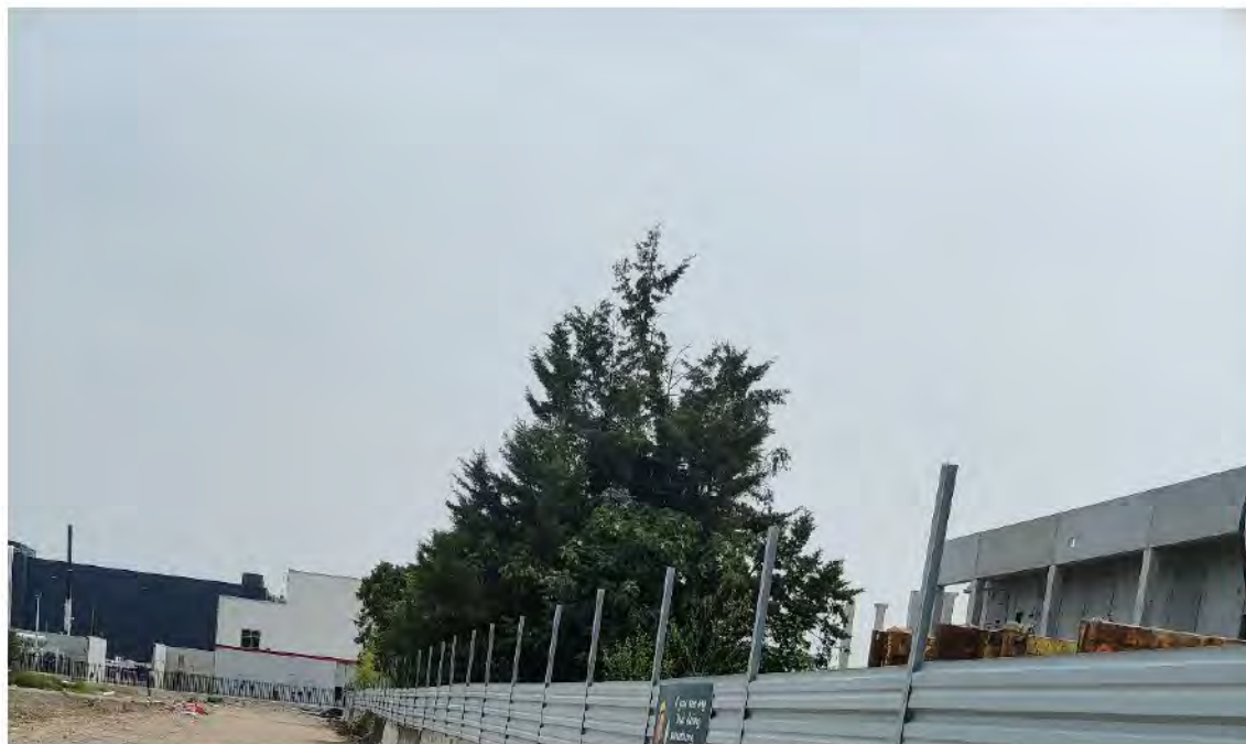
Vista della fascia alberata di altra proprietà posta all'interno dell'area di cantiere a sud,.
