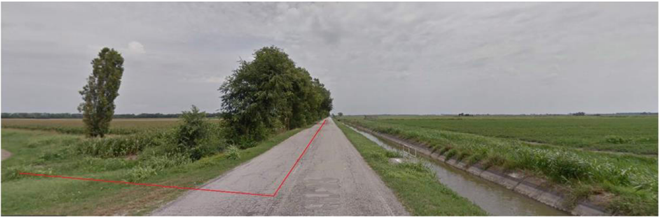
Figura 3.18 – Metanodotto - Punto di “ingresso” sulla SP 79
