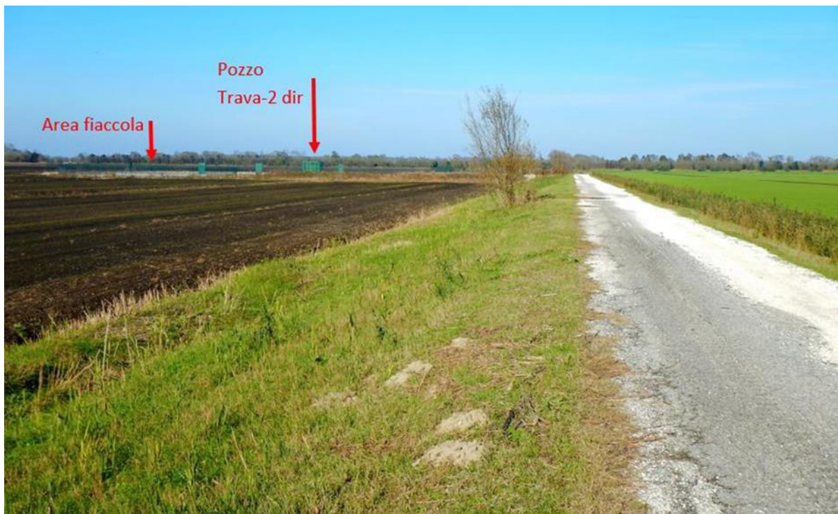
Figura 4.89 – Strada di Accesso all'Area Pozzo Trava 2 dir
