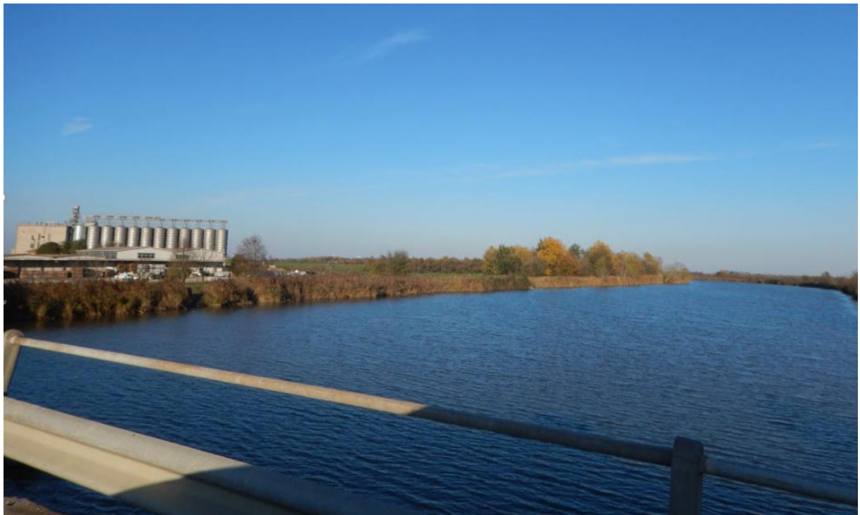
Figura 4.77 – Canale Circondariale a Sud di Ostellato presso SP 71
