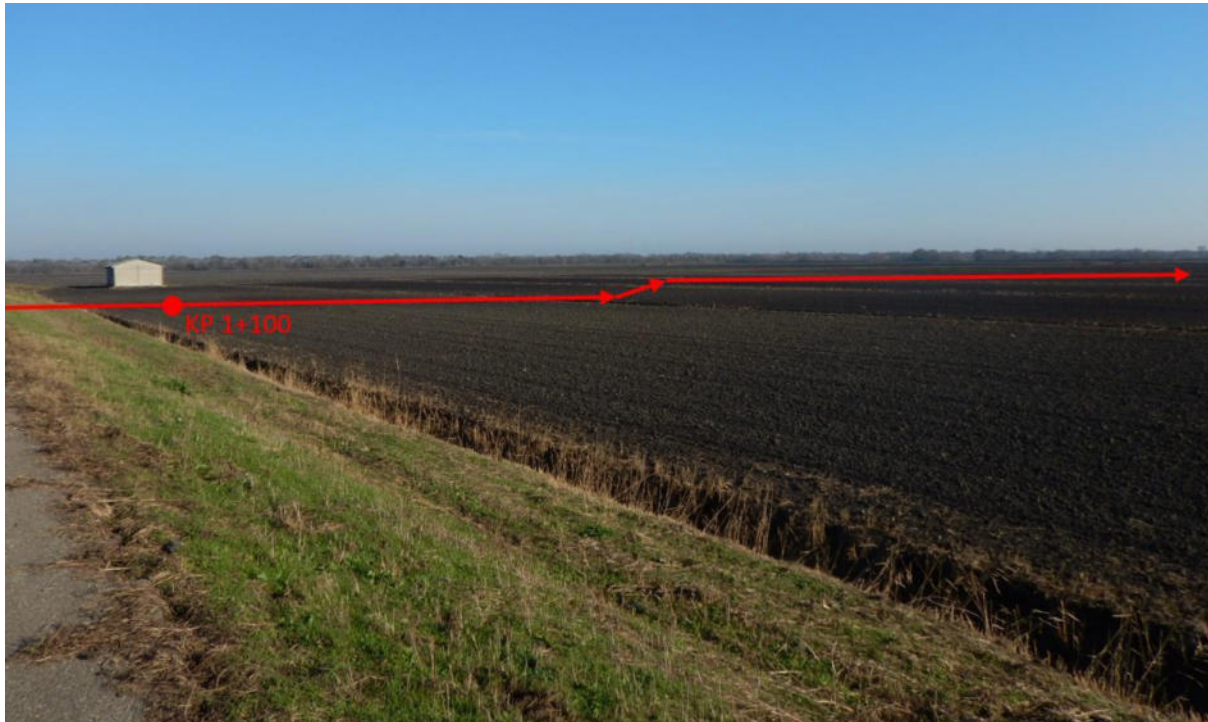
Figura 3.14 – Metanodotto – Ripresa Fotografica in Prossimità di Attraversamento Stradale
