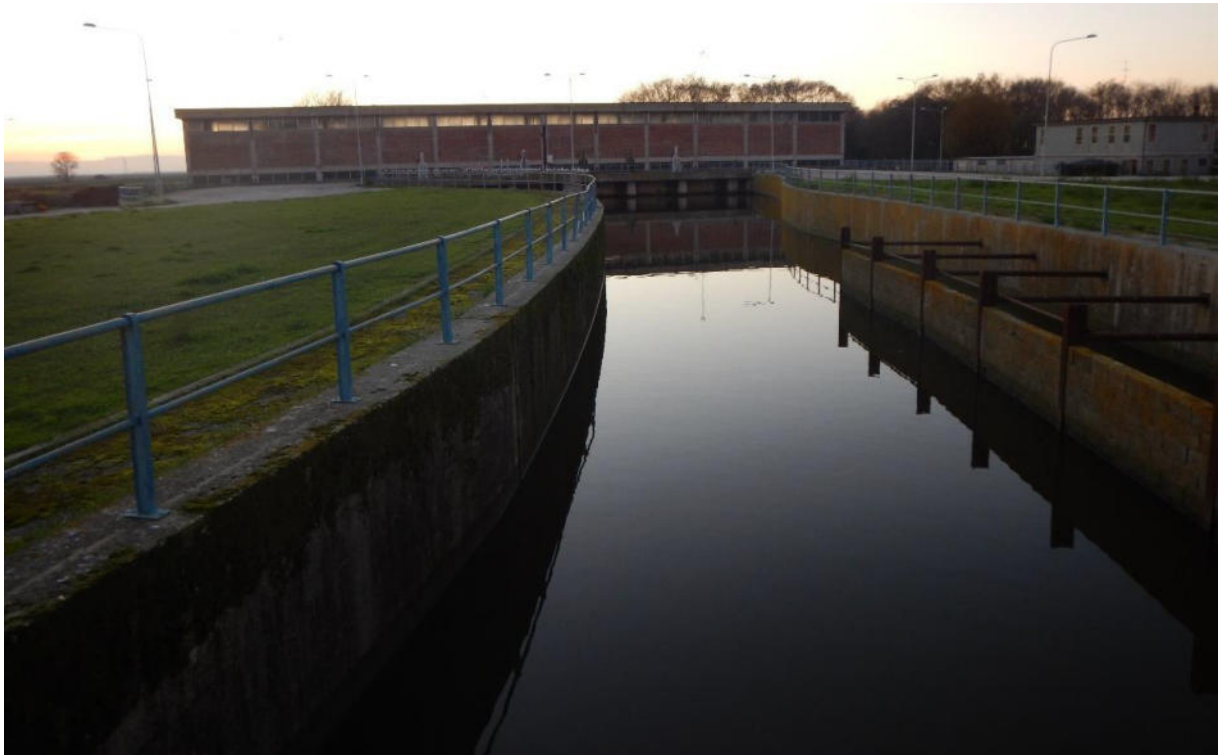
Figura 4.98 - - Impianto Idroforo Fosse
