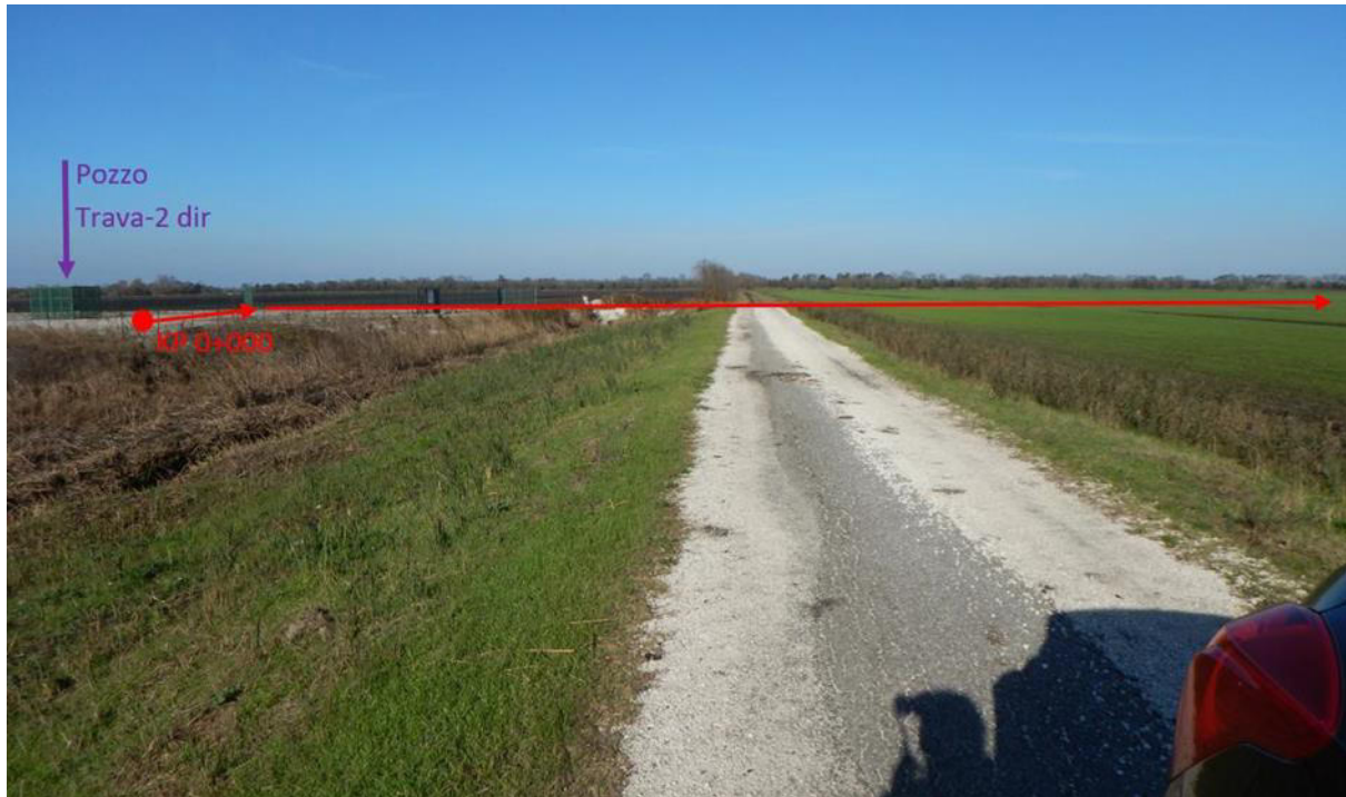
Figura 3.12. Metanodotto - Ripresa Fotografica in Prossimità dell'Area Pozzo Esistente (Attraversamento Strada Accesso Area Pozzo)
