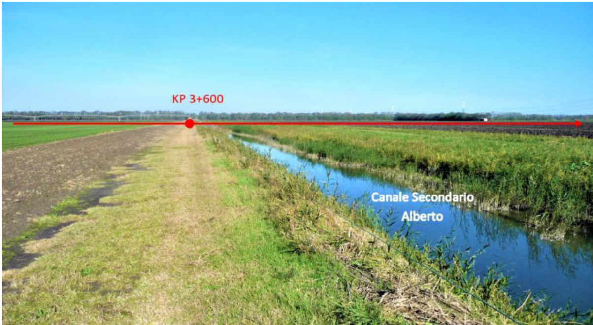
Figura 3.16 – Metanodotto – Ripresa Fotografica Attraversamento Canale Secondario Alberto
