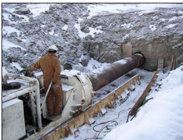
Figura 3.30– Realizzazione di attraversamento mediante presso trivella (Spingitubo)
