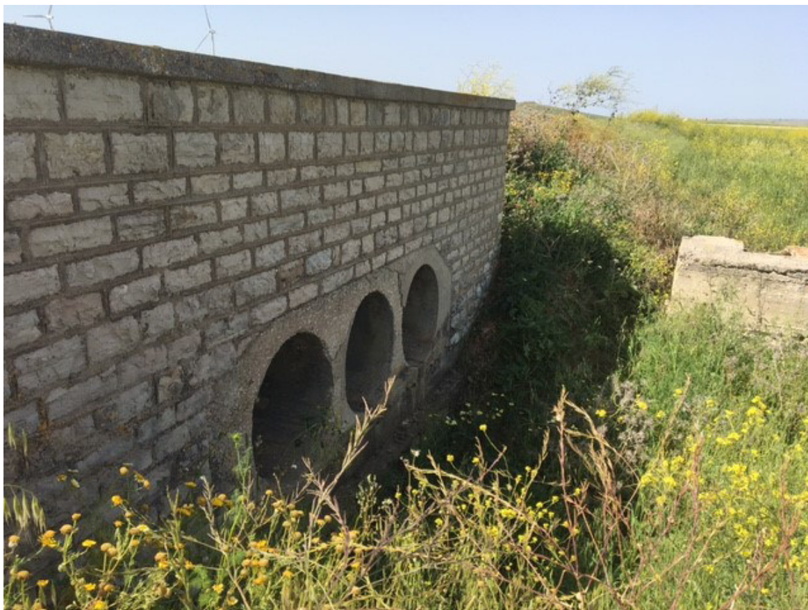
Figura 5.24 – Foto dell’elemento idrico non demaniale individuato su CTR 2012-2013 attraversato dal cavidotto 36 kV di collegamento tra la cabina di raccolta e trasformazione a 36 kV (“Area A”) e la cabina di sezionamento su manufatti esistenti
