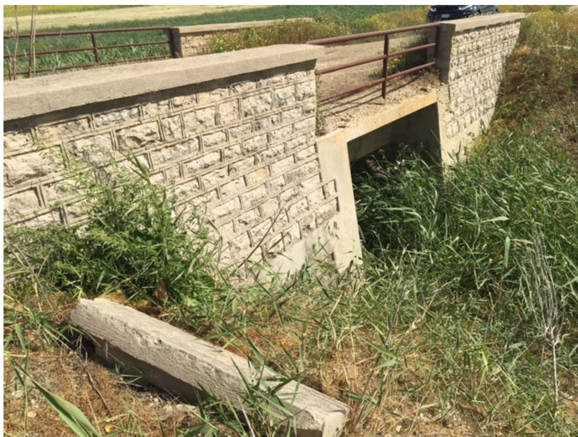
Figura 5.26 – Foto dell’elemento idrico non demaniale individuato su CTR 2012-2013 attraversato dal cavidotto 36 kV di collegamento tra la cabina di raccolta e trasformazione a 36 kV (“Area A”) e la cabina di sezionamento con collocazione su manufatti esistenti
