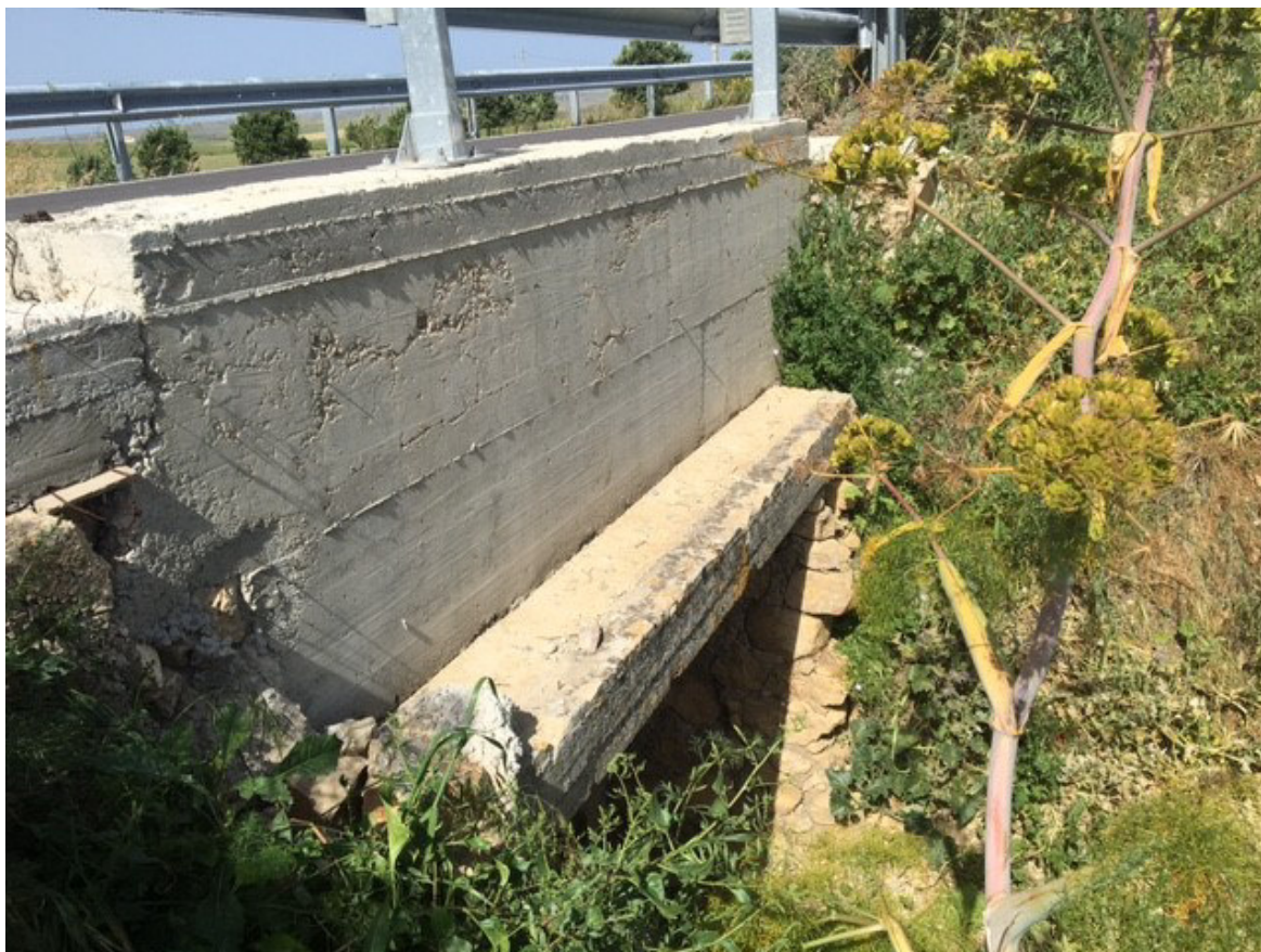
Figura 5.28 – Foto dell’elemento idrico non demaniale individuato su CTR 2012-2013 attraversato dal cavidotto 36 kV di collegamento tra la cabina di raccolta e trasformazione a 36 kV (“Area A”) e la cabina di sezionamento con collocazione su manufatti esistenti
