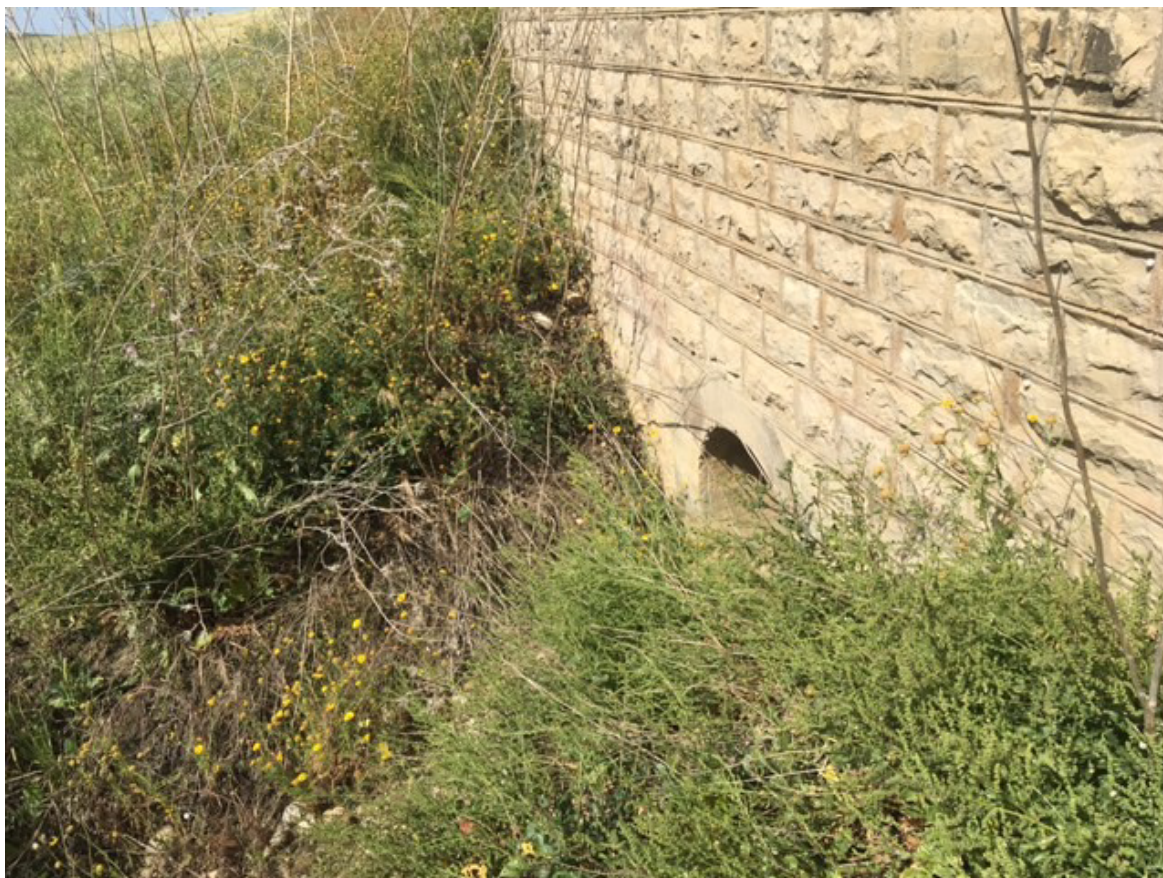
Figura 5.42 – Foto dell’elemento idrico non demaniale non individuato su CTR 2012-2 attraversato dal cavidotto 36 kV di collegamento tra la cabina di raccolta e trasformazione a 36 kV (“Area A”) e la cabina di sezionamento 013 attraversato dal cavidotto 36 kV di collegamento tra la cabina di sezionamento e la cabina di raccolta e trasformazione (“Area A”) con collocazione su manufatti esistenti
