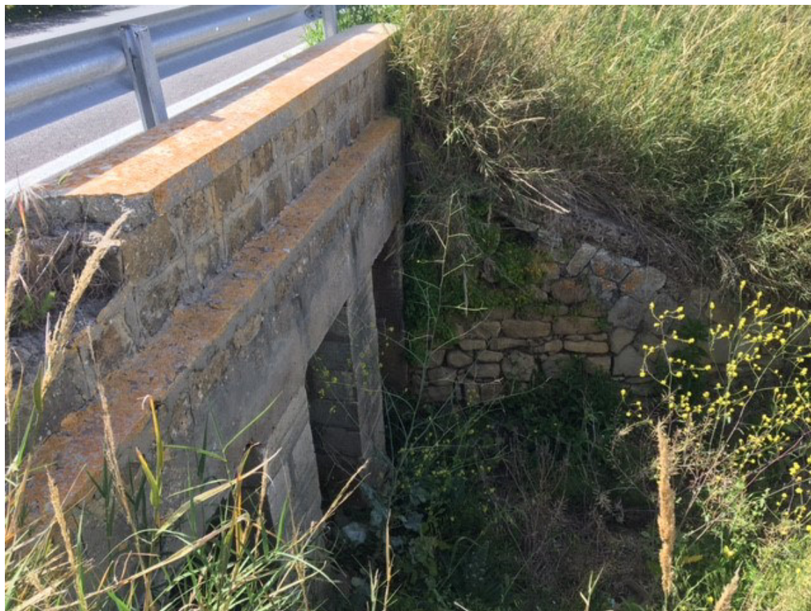
Figura 5.32 – Foto dell’elemento idrico non demaniale individuato su CTR 2012-2013 attraversato dal cavidotto 36 kV di collegamento tra la cabina di raccolta e trasformazione a 36 kV (“Area A”) e la cabina di sezionamento con collocazione su manufatti esistenti
