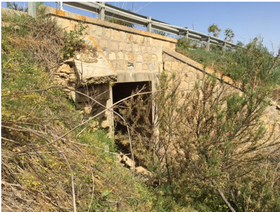
Figura 5.36 – Foto dell’elemento idrico non demaniale individuato su CTR 2012-2013 attraversato dal cavidotto 36 kV di collegamento tra la cabina di raccolta e trasformazione a 36 kV (“Area A”) e la cabina di sezionamento con collocazione su manufatti esistenti
