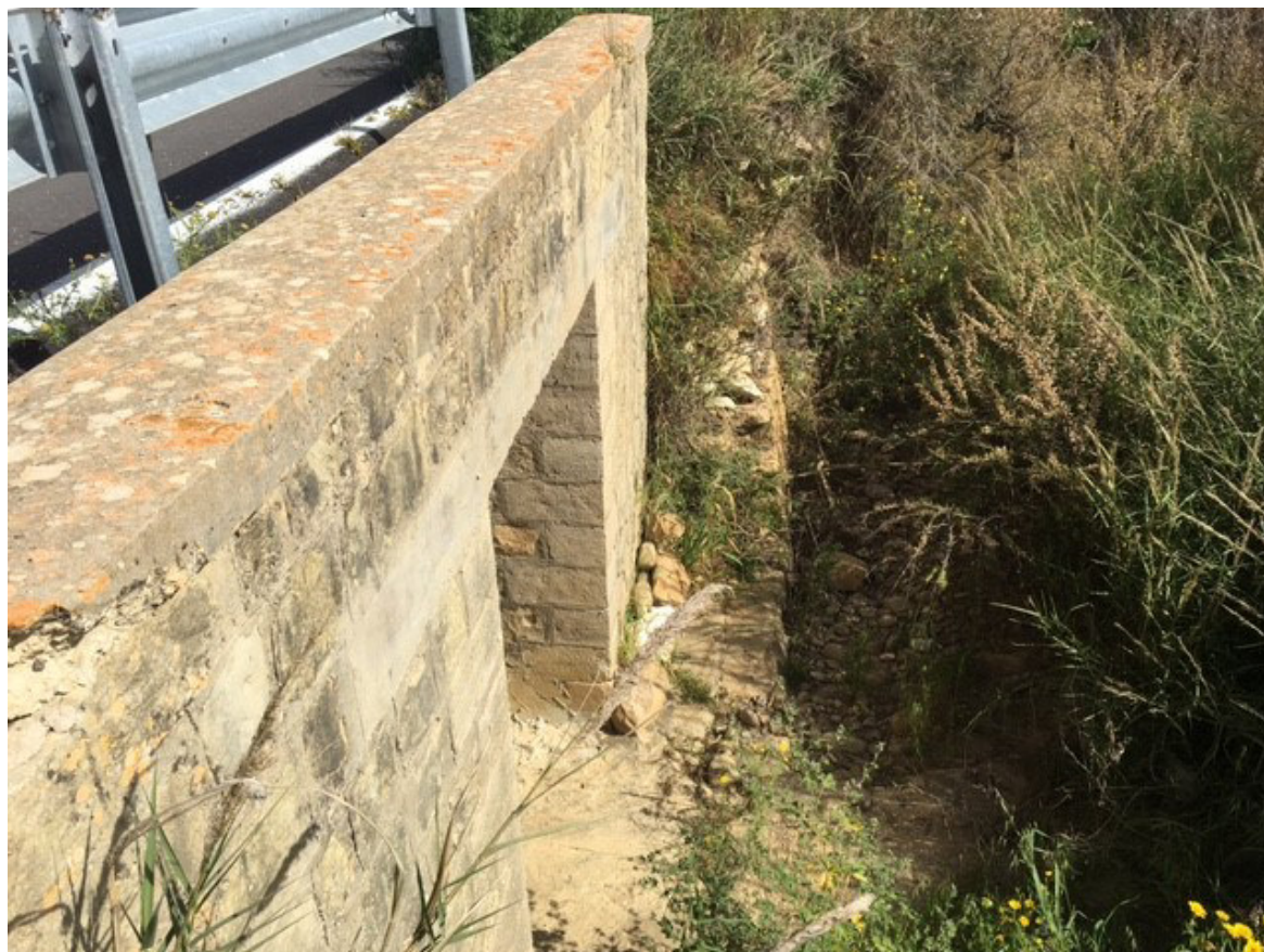
Figura 5.34 – Foto dell’elemento idrico non demaniale individuato su CTR 2012-2013 attraversato dal cavidotto 36 kV di collegamento tra la cabina di raccolta e trasformazione a 36 kV (“Area A”) e la cabina di sezionamento con collocazione su manufatti esistenti
