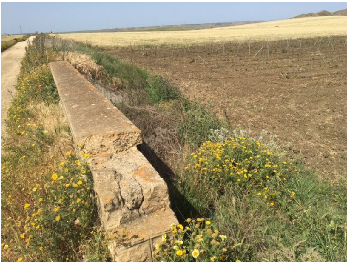
Figura 5.22 – Foto dell’elemento idrico non demaniale individuato su CTR 2012-2013 attraversato dal cavidotto 36 kV di collegamento tra la cabina di raccolta e trasformazione a 36 kV (“Area A”) e la cabina di sezionamento con collocazione su manufatti esistenti
