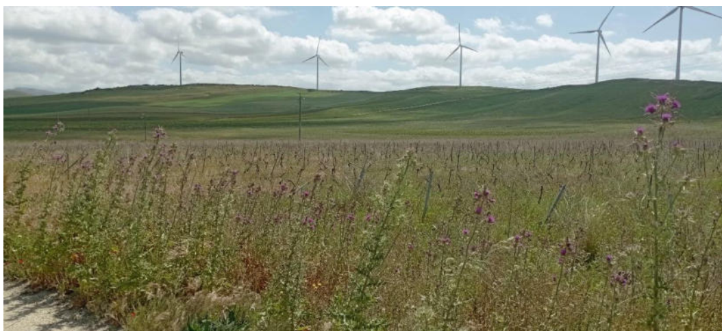
Figura 9.20 – Foto scattata in sito dello stato agricolo attuale dell’area nuova SE RTN “Borgo Zaffarana”
