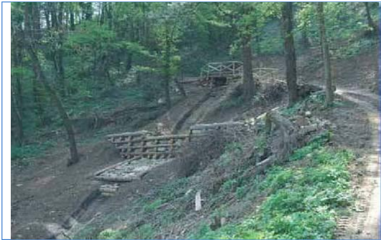
Figura 8-8 – Esempio di briglie in legname e pietrame - Fonte HE
