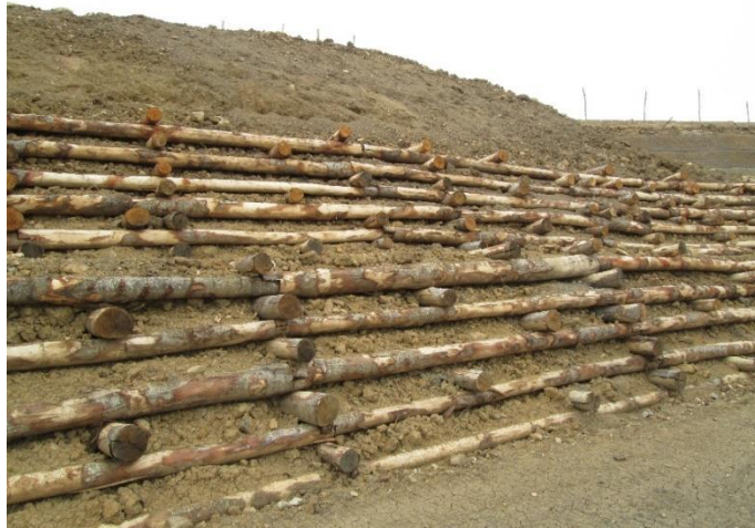
Figura 8-3 – Esempio di opera in palificate in legname - Fonte HE
