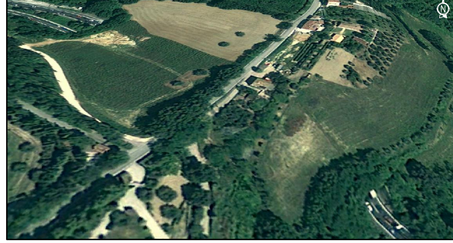
Vista ravvicinata prospettica stato esistente anno 2010
